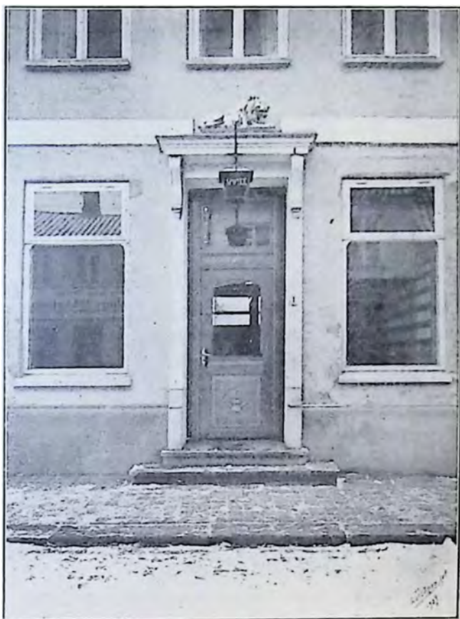
Middelfart Apotek. Parti af Indgangen efter Ombygningen 1926.
