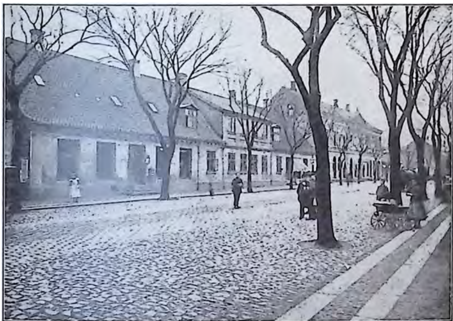
Løve-Apoteket i Hjørring for Ombygningen 1913—14.
