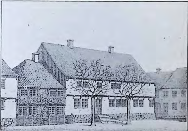
Assens Apotek før Ombygningen i 1847—48.*)
