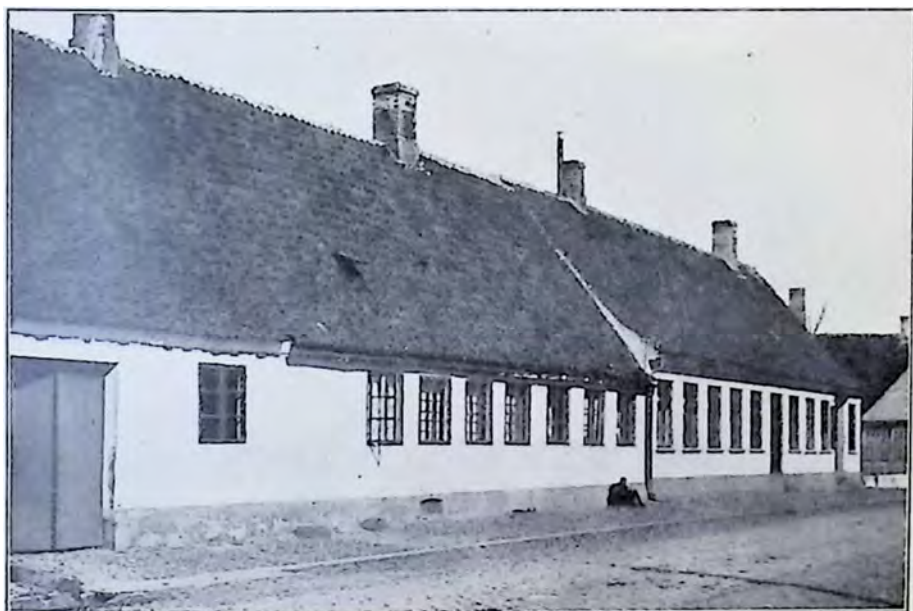
Frederikssund Apotek for Ombygningen 1908.
