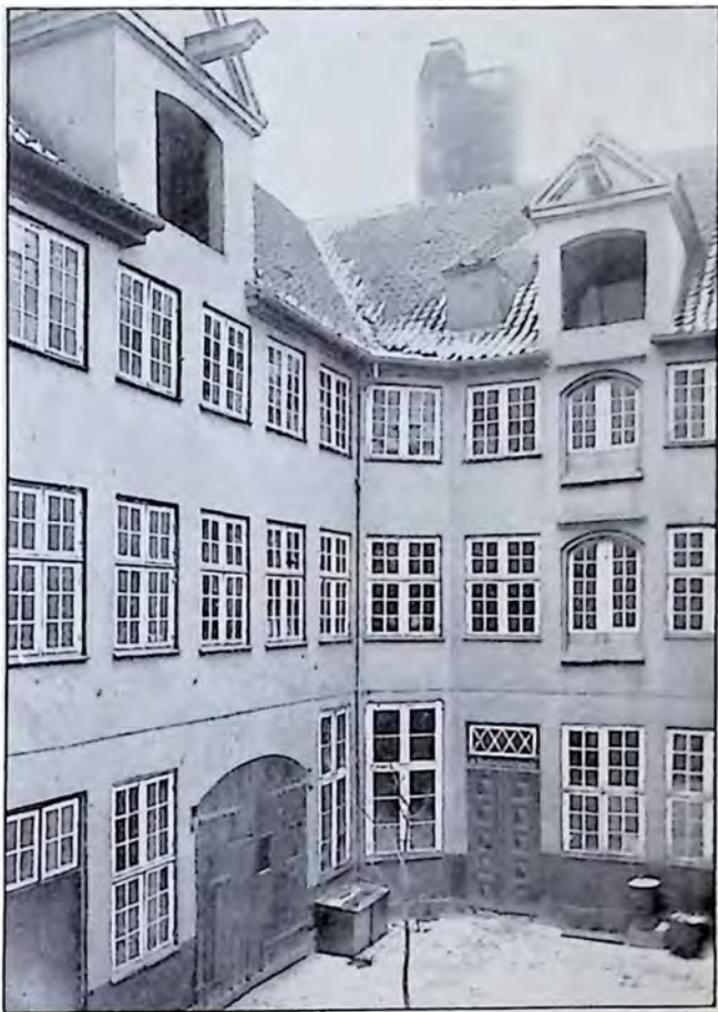
Geardparti fra Christianshavns Apotek. I Baghusets Stueetage Laboratorium.
