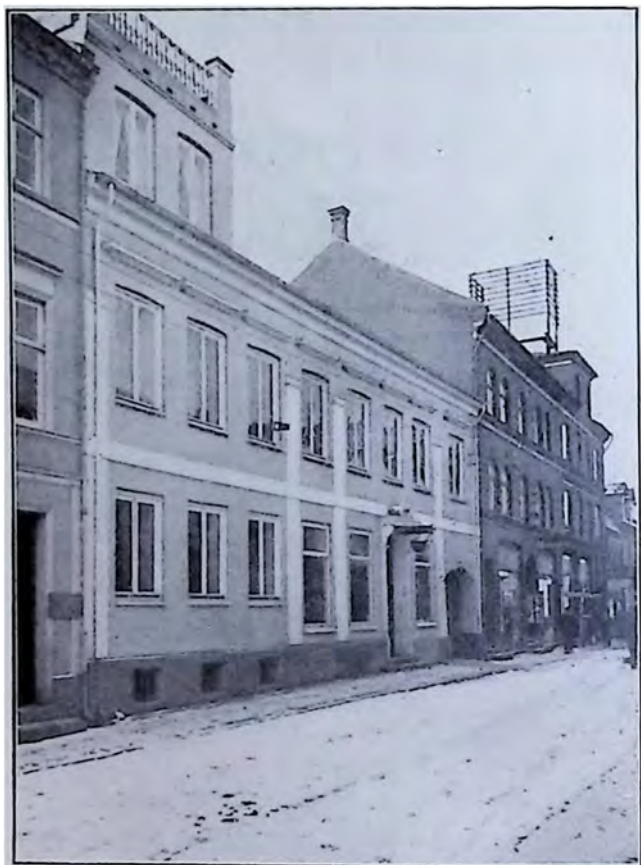
Middelfart Apotek. Ejendommens Facade efter Ombygningen 1926.
