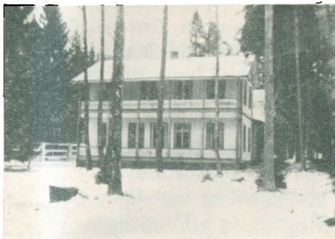
En af Indkvarteringsbygningerne.
