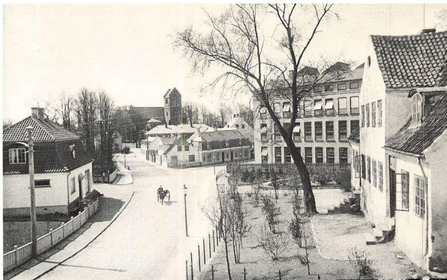
Lundtoftevej set fra nord. Til højre ses »Brunborg«, bagved en af gardinfabrikens store bygninger, der ligger, hvor Bleggården tidligere lå. Det kgl. Bibliotek.
