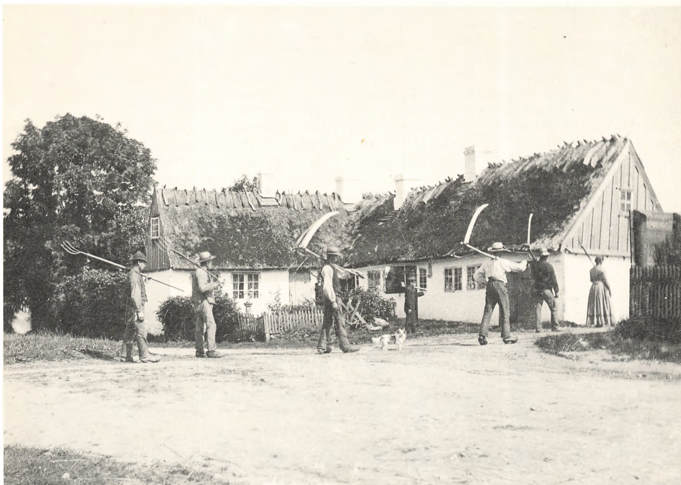
Nørregade 14. Nedrevet 1962. Ældre foto. Byhistorisk Samling.
