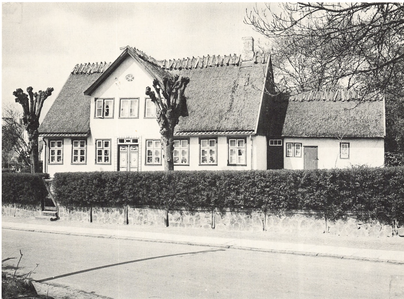
Støvlet-Kathrines Hus, Lundtoftevej 31. Ældre foto. Teknisk forvaltning.
