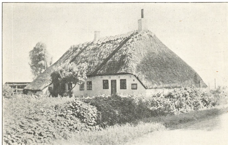
Hus ved Landevej.
