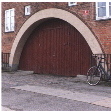
Port på Katrinedalsvej over vandledning.
