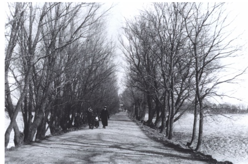
Tværdæmningen med piletræer på begge sider 1921.
