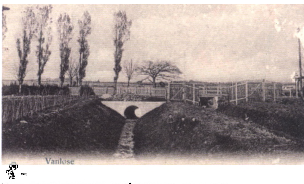
Ledager Bro under opførelse nord for Snydebro omkring 1930.
