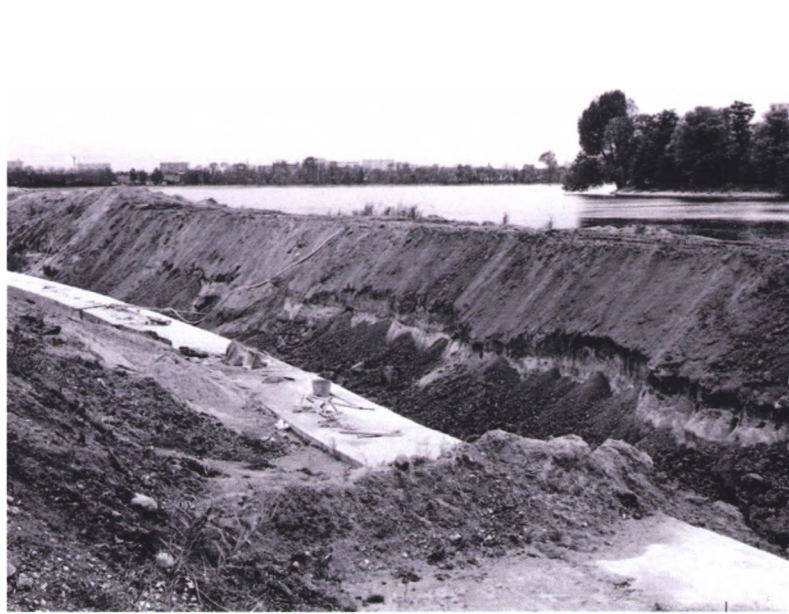
Udgravning til forsinkelsesbassin i Damhussøen 1977.
