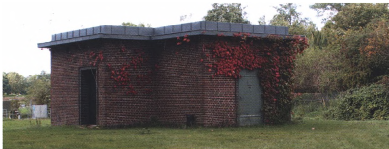
Pumpestationen i Damhusengen.
