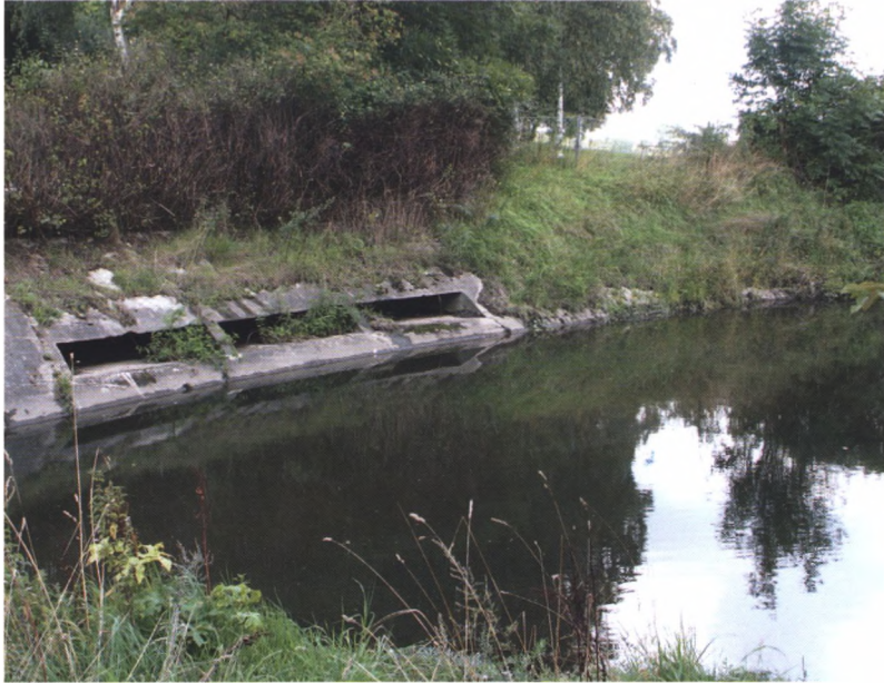
Overløbsværk ved Sorte Bro.
