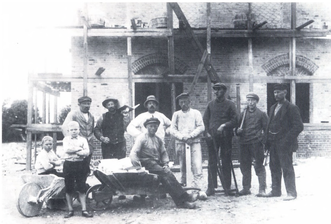
Ombygning af Vesløs Station 1919. Nr. 3 fra venstre i bagerste række murermester Svend Pedersen, Vesløs, der byggede de fleste af husene i den hurtigtvoksende Vesløs Stationsby. (Lokalhistorisk Forening for Sydhavnæs).
