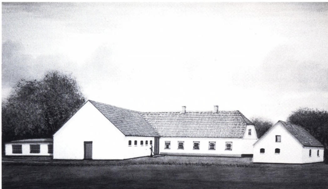
I årenes løb byggede Valdemar Nielsen en ny vognbygning mod øst og et lavt hønsehus mod vest.
