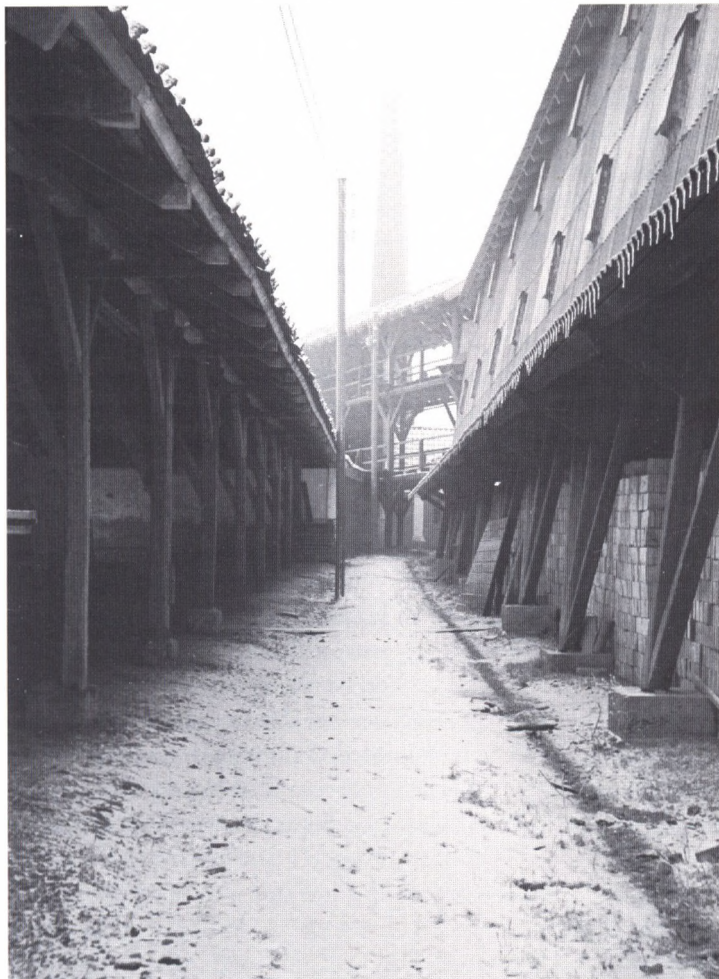
Skovsgaard Teglværk, fotograferet en vinterdag i 1955. Ovnbygningen til højre, tørreladen til venstre, og i baggrunden dampmaskinens skorsten.
