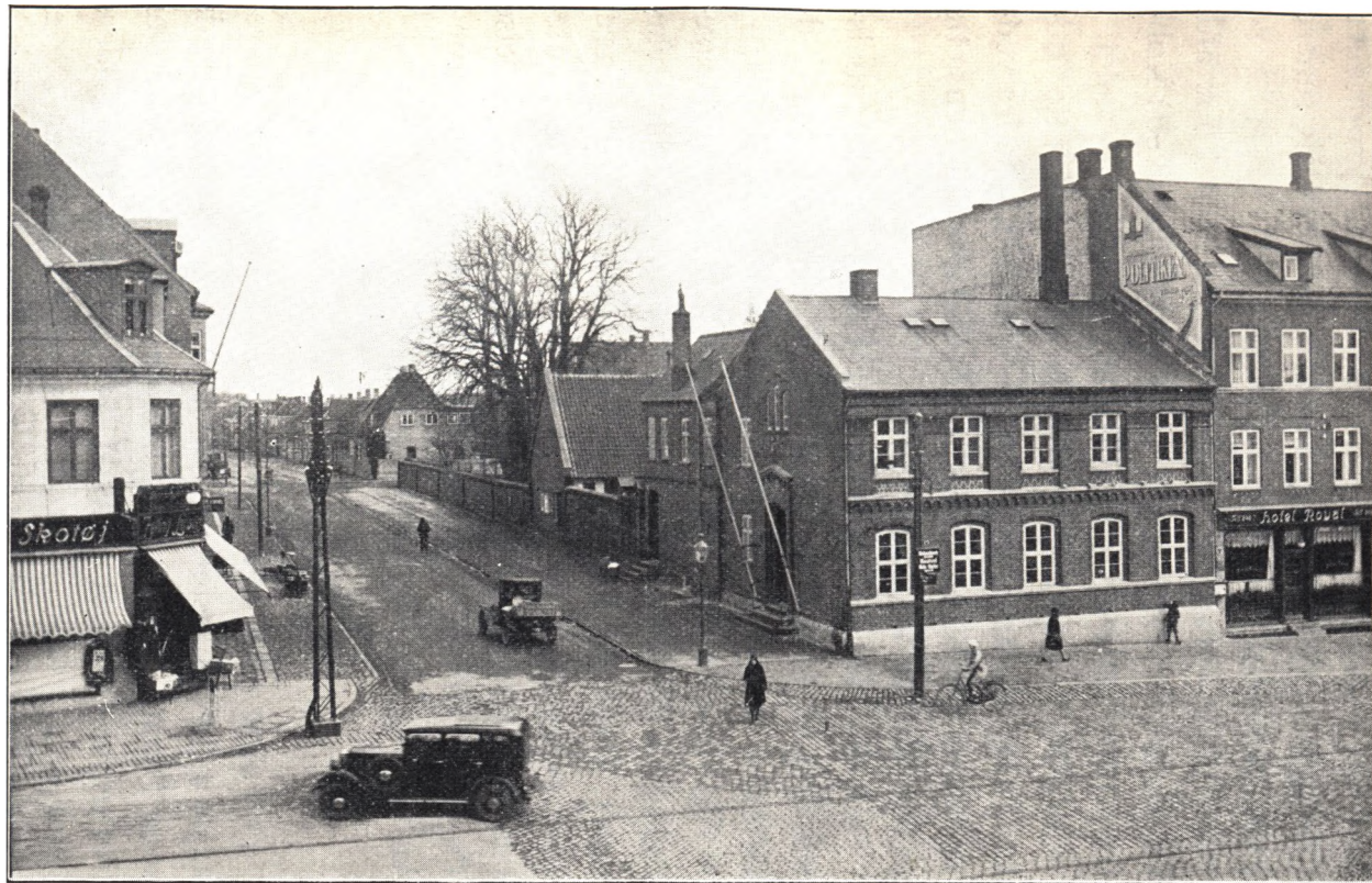
Sparekassens Bygning mod Torvet og St. Knudsgade (1932).
