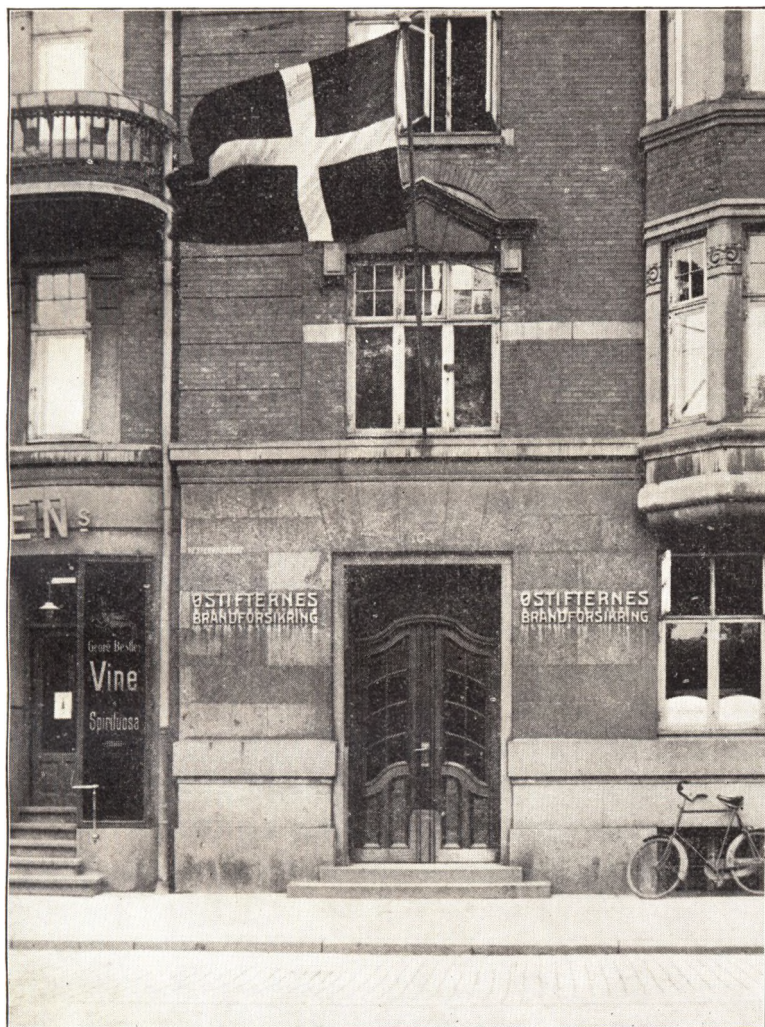
Østifternes Brandforsikrings Ejendom i København, Vestervoldgade 104.
