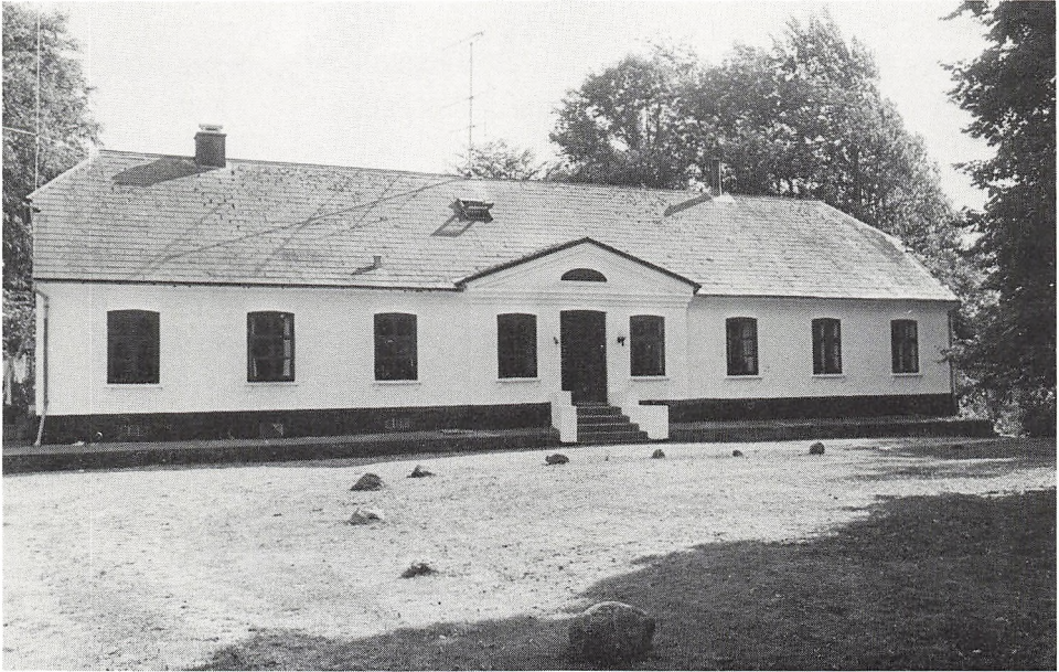
Malt præstegård. SMS fot. 1983. Stuehusets gårdside.
