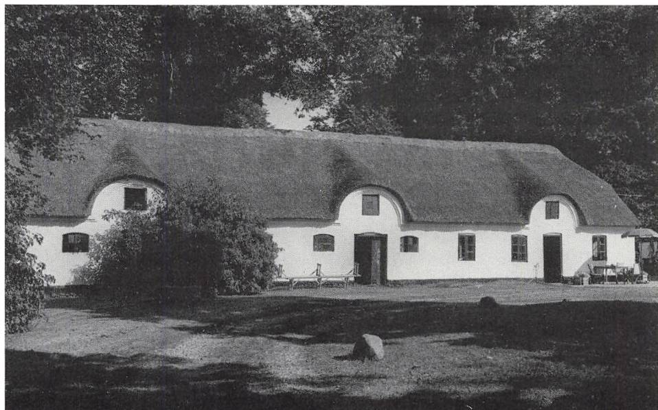
Malt præstegård. Østre sidelænges gårdside. SMS fot. 1983.
