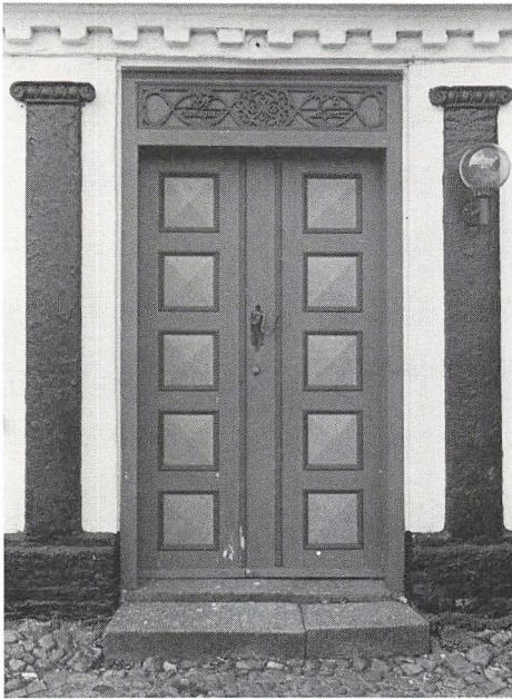
Toftegaard, 1845. Hoveddør. Selve døren er fornyet, men overvindue og dørgreb er genanvendt. Pilastrene udgår fra øverste sokkelled og når slet ikke op til sparrenkopgesimsens underside. SMS fot. 1983.
