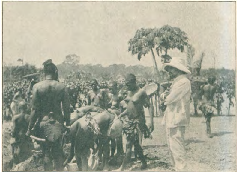
Abarambokvinder bygge et Hus paa Stationen Surango i Uellé.
