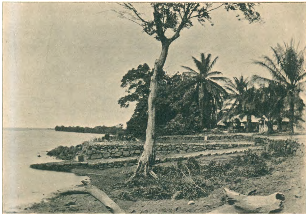
Strandparti ved Tumbasøen udfor Missionsstationen Ikoko. Sten bortsprængt, Buske og Krat bortryddede, Terrasser byggede og Mure rejste af Missionær Sjöblom. (Fot. tilh. Fru E. Sjöblom.)
