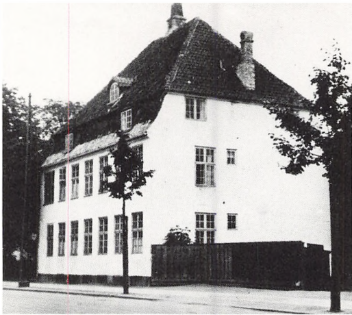
Hovedbygningen set fra nordvest ca. 1940. Alle gavlvinduerne i de to hovedetager og skorstenen i valmtaget skyldes ombygningen i 1917.
