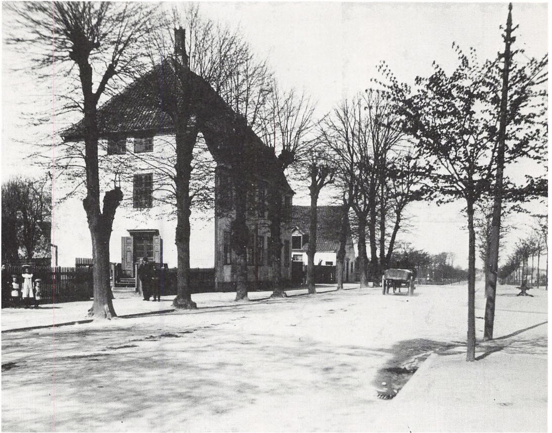
Godthåb 1908. Godthåbsvej er udvidet, og stakittet og indgangsdøren flyttet. Foto i Københavns bymuseum.
