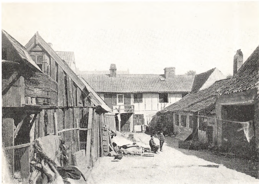
HJØRNESTEDET BREDEGADE 2 – ALLEGADE 31 ca. 1895. (Fot. Barby). Gaardinteriøret svarer til det paa modsatte Side viste Gadeexteriør. De inden Nedrivningen stærkt forfaldne Rønner var opført med Udlejning for Øje.
