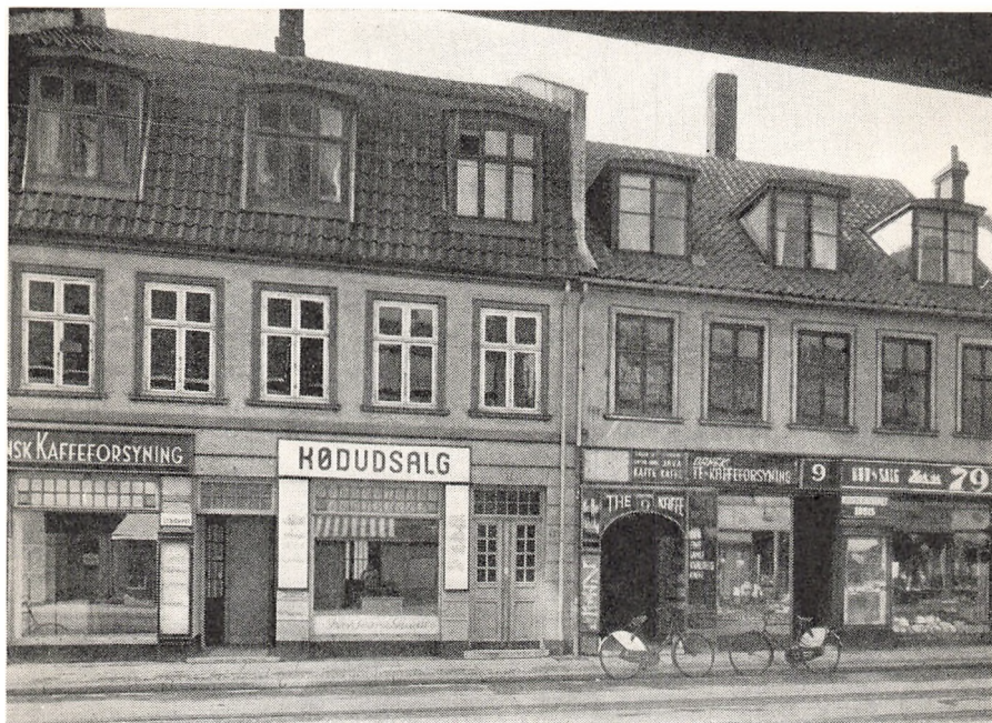
SMALLEGADE NR. 7 OG 9 1941. (Fotografi). Den første mere moderne Bebyggelse af Gaden havde halvvejs provinsiel Karakter, mere beskedne Huse paa et Par Etagers Højde, men allerede i 1860erne kom det udprægede Kasernebyggeri i Gang.
