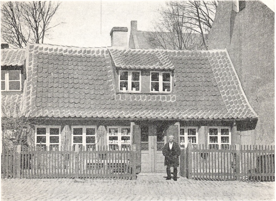
BREDEGADE 28 INDEN NEDRIVNINGEN 1889. (Fot. Barby). Saa uanselige har i hvert Fald Kvarterets Etetages Huse været i ældre Tid. I Huset, som stammede fra sidste Halvdel af 1700 Tallet, var der længe Traktørsted, siden Urtekramforretning.
