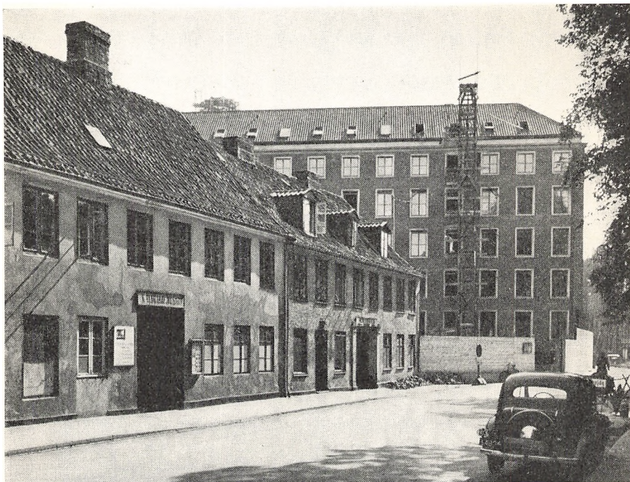
BREDEGADE 24-22 SET IMOD RAADHUSET 1952. (Fot. Jonals). Billedet viser to af Gadens tre ældre Ejendomme fra Tiden omkring Aar 1800, de eneste indenfor det her behandlede Omraade, der kan siges at have nogen arkitektonisk Værdi.
