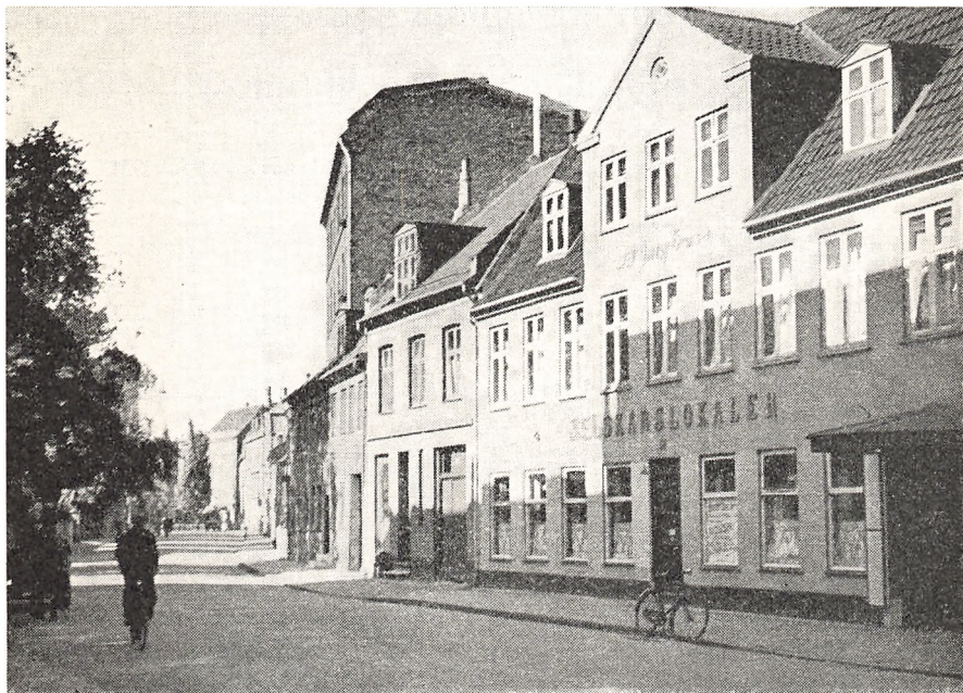
PARTI FRA BREDEGADE SET MOD VEST. (Fotografi 1941). I Forgrunden de samme Ejendomme som paa det ældre Billede overfor, men Ombygningen af Nr. 12, der fandt Sted i 1927, og Opførelsen af den høje Bygning Nr. 18, har fuldstændig ændret Helhedsindtrykket.
