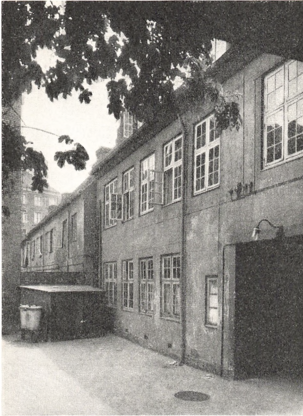
GAARDFACADER SET FRA BREDEGADE 26 IMOD ØST 1952. (Fot. Jonals). Det er Bagsiderne af Bydelens ældste Huse, man ser paa Billedet, stilfærdigt ensformige Husfacader, som de byggedes i Klassicismens Tid, omkring forrige Aarhundredskifte.
