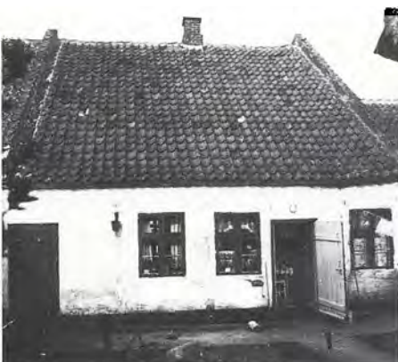
Fiskergade 5A, den overkalkede bagside
