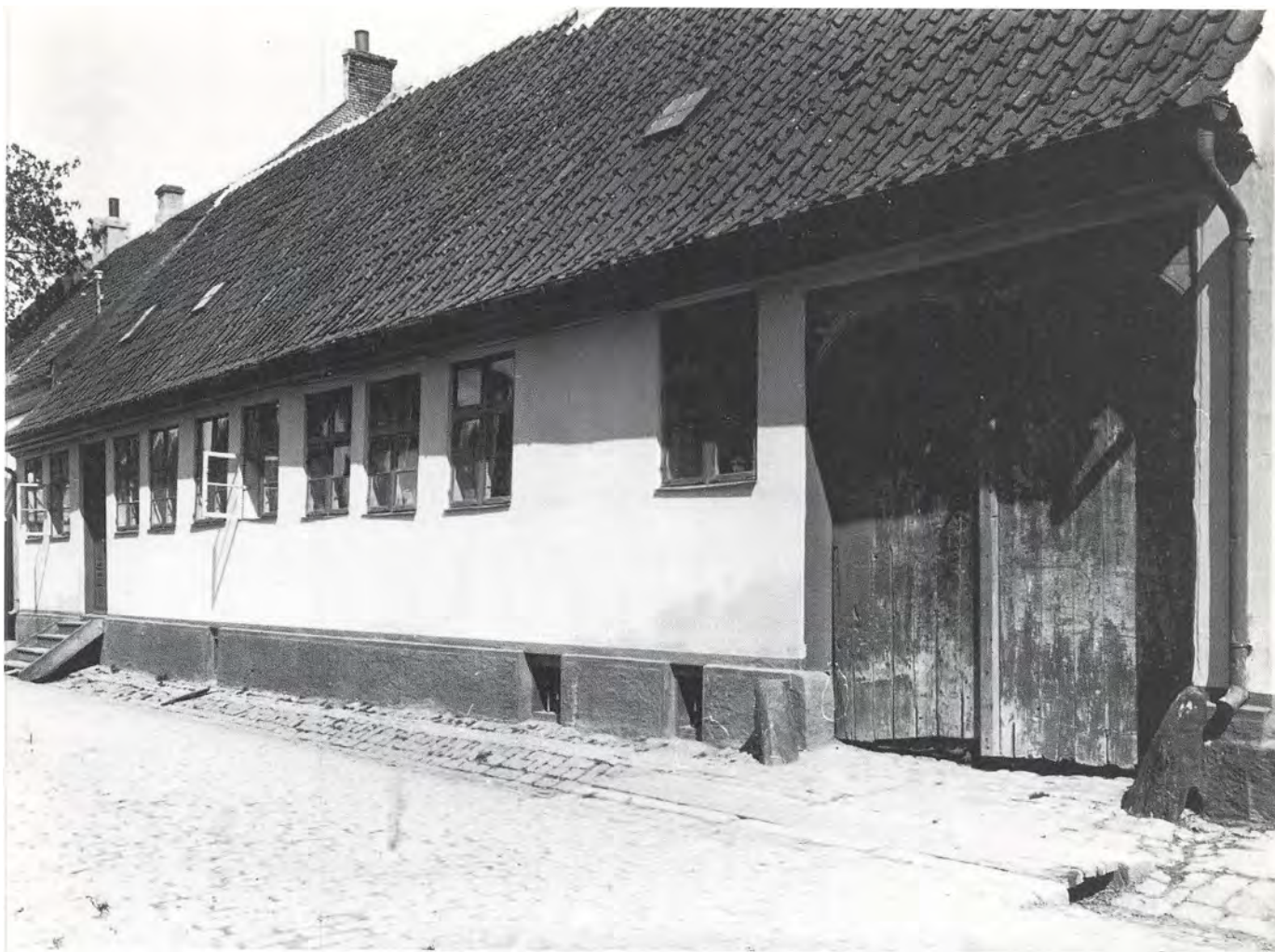
Adelgade 15. Facaden før tilbagerykningen. Porthammeren ses over porten, som blev lukket i forbindelse med ombygningen. Hugo Mathiessen foto, 1915 (Nationalmuseet)
