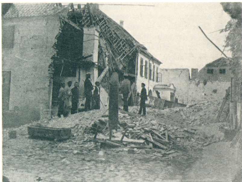
Efter Hørfabrikkens Eksplosion den 20. August 1873.
