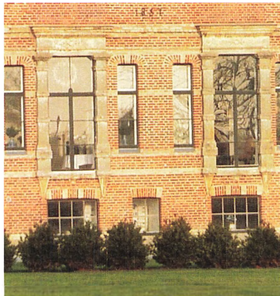
Udsnit af facade mod haven med de påsatte pilastre.
