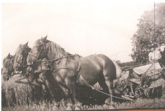
Omkring 1900 kom så selvbinderen. Denne maskine var i stand til skære kornet over (meje), samle i neg og binde neget sammen med bånd. Carl Bernhard Jørgensen med selvbinder. Høsten sker på Nordskovsgården i 1953-1955.
