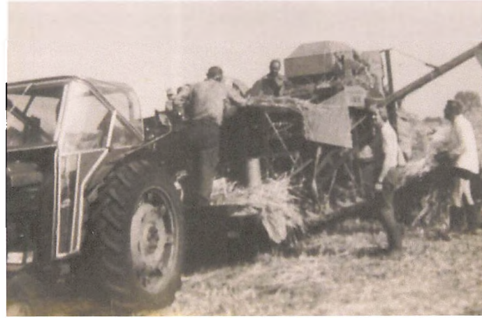
Billedet forestiller en langhalmmaskine, som er bygget sammen med en bugseret Dronningborg mejetærsker. Sejersbøl lavede langhalm helt hen til 1976. Det var en god forretning, indtil markedet blev ødelagt af tækkerør fra Ungarn.
