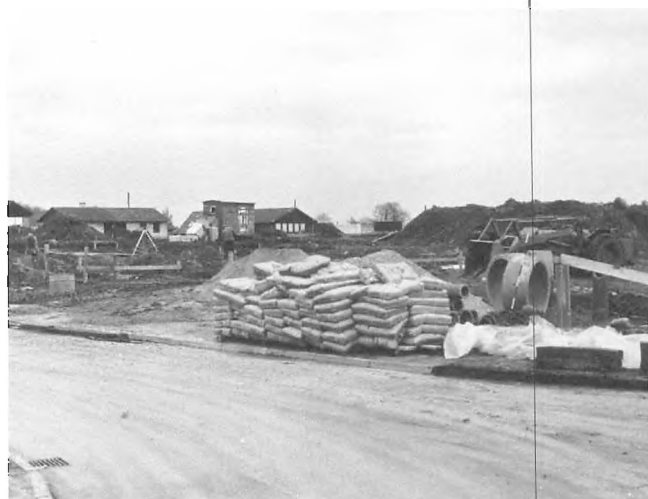
Figur 6: Byggeriet af Brugsen er godt i gang her den 15. november 1968, ti dage efter det første spadestik var taget. (Foto udlånt af SuperBrugsen. Fotograf formentlig Henry Rasmussen).
