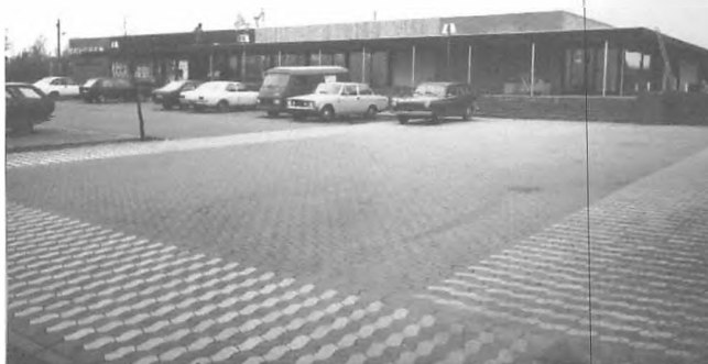
Figur 16: Brugsen efter udvidelsen i 1978 fra 367 til 903 m 2 . Der er endnu ikke malet på træværket på taget på den nye del af bygningen. (Foto udlånt af Super-Brugsen. Fotograf formentlig Henry Rasmussen).
