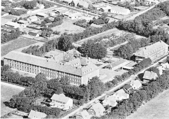
Brønderslev sygehus. (Luftfoto: T. Balslev 1969).
