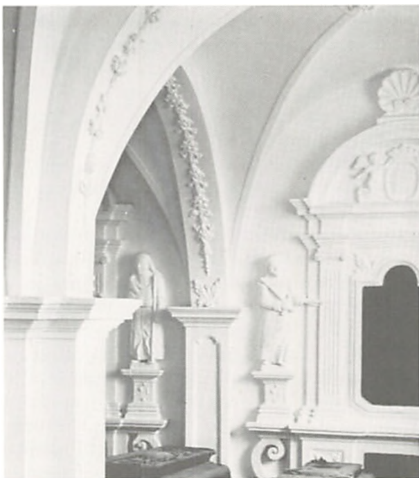
Højbjerg kirke, gravkapellet. Til venstre centralsøjlen der bærer de fire krydshvælv. Fot. 1972.
