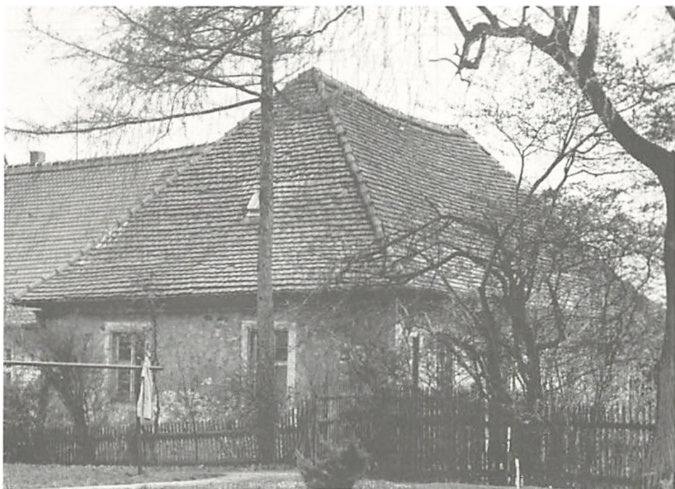
Erblehgerichts nordvestre hjørnebygning opført ca. 1706. Husets vinduer og tagform virker særdeles talende.
