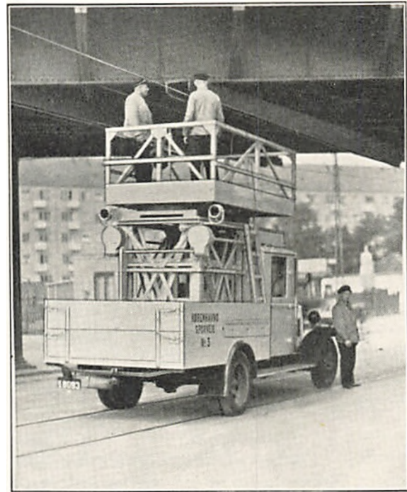
Fig. 75. Ledningsarbejde under Viadukt
