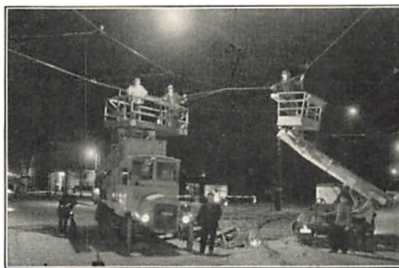
Fig. 77. Ledningsarbejde om Natten
