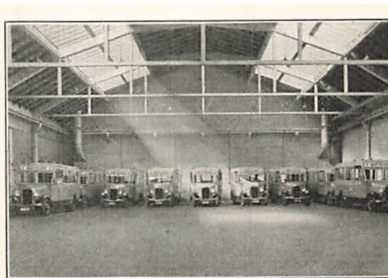
Fig. 56. Garageanlæggets nyeste Hal. Opført 1933. Taget bæres af Jernbetonbuer
