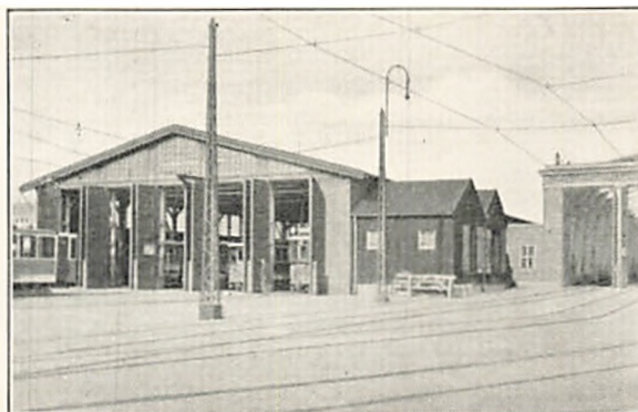
Fig. 41. Den ældste Del af Sundby Remise. Opført som Bindingsværksbygning
