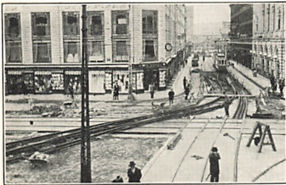
Fig. 62. Sporarbejder paa Raadhuspladsen ved Omlægningen 1931
