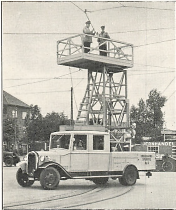
Fig. 74. Ledningsarbejde i normal Højde
