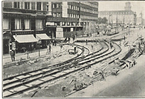
Fig. 61. Sporarbejder i Vesterbrogade i Forbindelse med Raadhuspladsens Omlægning 1931
