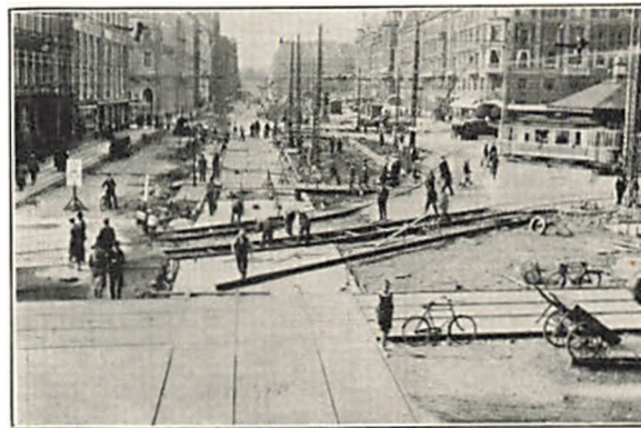
Fig. 63. Sporarbejder paa Raadhuspladsen ved Omlægningen 1931
