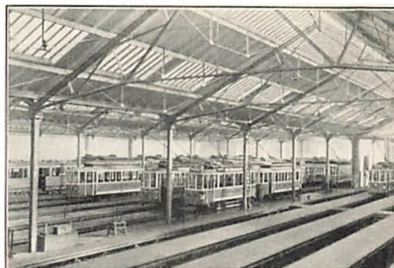
Fig. 45. Det indre af Svanemølle Remise. Taget bæres af Jernspærfag
