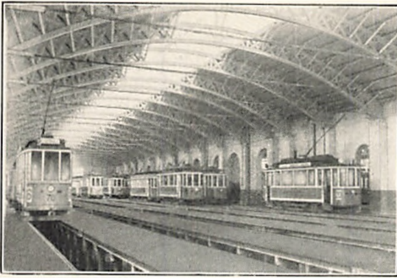
Fig. 51. Nørrebro Remise. Den ene af de to under Krigen byggede Haller. Taget bæres af Gitter-Træbuer
