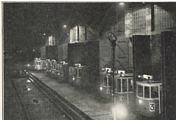
Fig. 54. Enghavevej Remise ved Nat. Pladsmanglen er følelig
