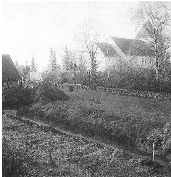
Lisbjerg kirke set fra nordøst. Til venstre i billedet anes stuehuset til den gamle gård „Kirkegård“, hvis nedrivning gav anledning til udgravningen. I forgrunden ses en af de første søgegrøfter.
