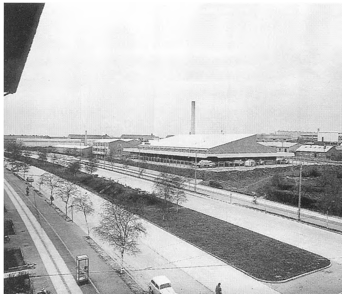
MD Foods standsede mælkeproduktionen på Centralmejeriet på Vestre Ringgade i 1989. Mejeriet, der her ses kort efter opførelsen i 1957-58 tilhørte oprindeligt De Forenede Mejerier, oprettet i 1899 ved sammenlægning af byens tidligste privatmejerier og senere – 1924 – omdannet til et andelsforetagende. Centralmejeriet kom selskabet til at hedde i 1968, da De Forenede Mejerier gik sammen med byens andet store andelsmejeri, Mejeriet Vesterbro (stiftet 1905). I 1977 blev Centralmejeriet, der i mellemtiden havde overtaget flere omegnsmejerier, en del af Mejeriselskabet Danmark. Bygningskomplekset er overtaget af byggefirmaet Mogens de Linde. Nogle af produktionsbygningerne vil blive nedrevet og grunden omdannet til centerbebyggelse med tre-etages facadebygninger langs Ringaden. (Foto til Erhvervsarkivet).
