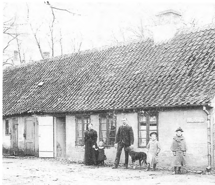
»Nøglen til Dameclosettet afhentes hos Opsynsmanden. 5 Øre Erlægges«.
