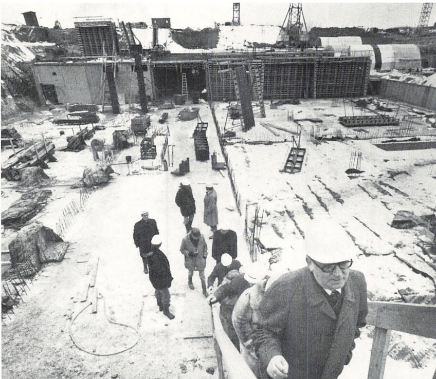
I gummistøvler og med sikkerhedshjælm blev pressefolkene vist rundt på byggepladsen.
