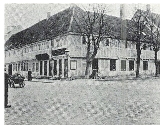
På grunden til den ny bankbygning lå tidligere »Den Holst'ske Købmandsgaard«, bygget 1723.
