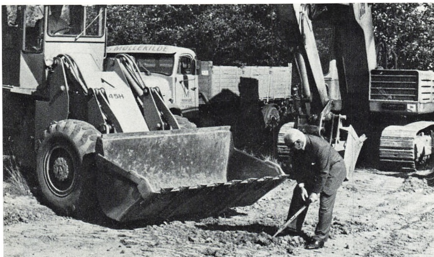
Direktor Bagge-Petersen tager det første spadestik til det store byggeri.
