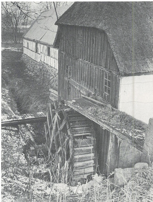
Rødkilde Vandmølle, der med et vandhjul på 5,6 m i diameter er landets største fredede vandmølle, er en af de tre, der nu får nyt tag.
