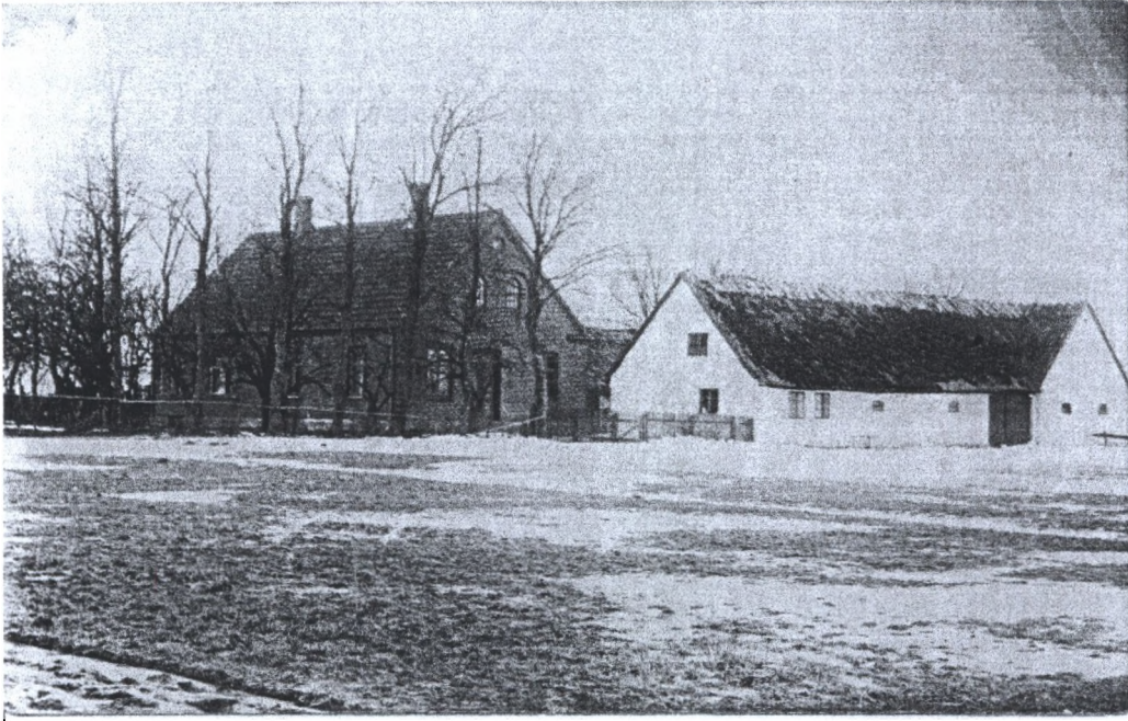
Maglemosegård Evetofte efter 1910. Der er bygget nyt stuehus i afstand fra udlængerne. Bemærk hesteomgangen helt ude til højre. Det var den tids kraftkilde. Elektriciteten kom i sognet 1925.
