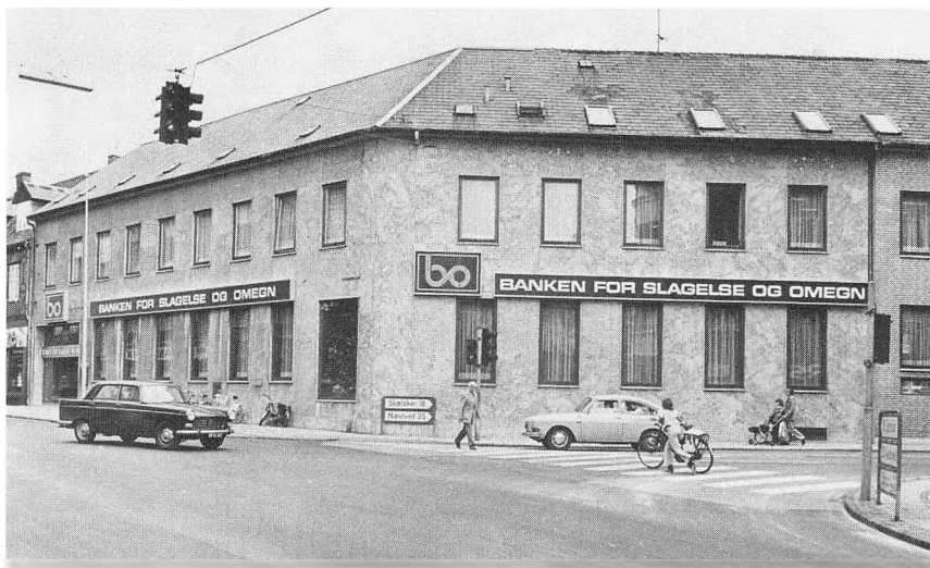
Banken i dag. Fra venstre Bredegade – til højre om hjørnet Bjergbygade – med mursten den »nye« afdeling, som fortsætter ud af billedet (det var denne del, der før ombygningen blev kaldt »borgmesterens bare ende«, fordi den dengang kun var beklædt med puds).
