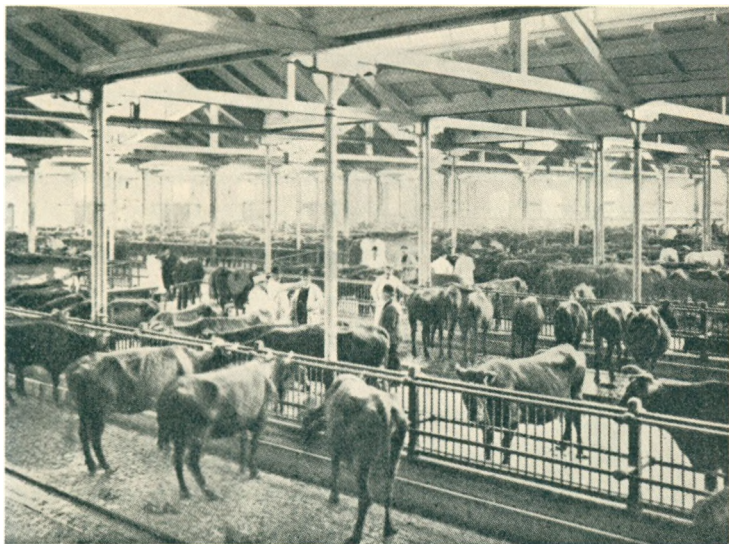
Fra Øxnehallen, som blev opført 1901. (Før og nu).
