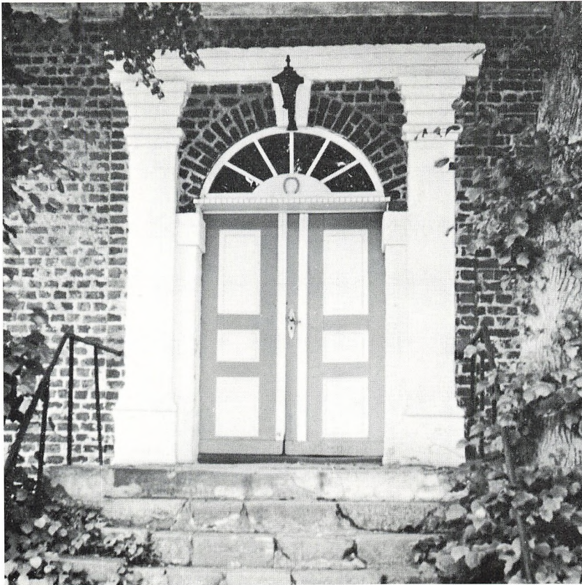
Fig. 5. Tårupgård, hovedindgang. Fot. 1963.
