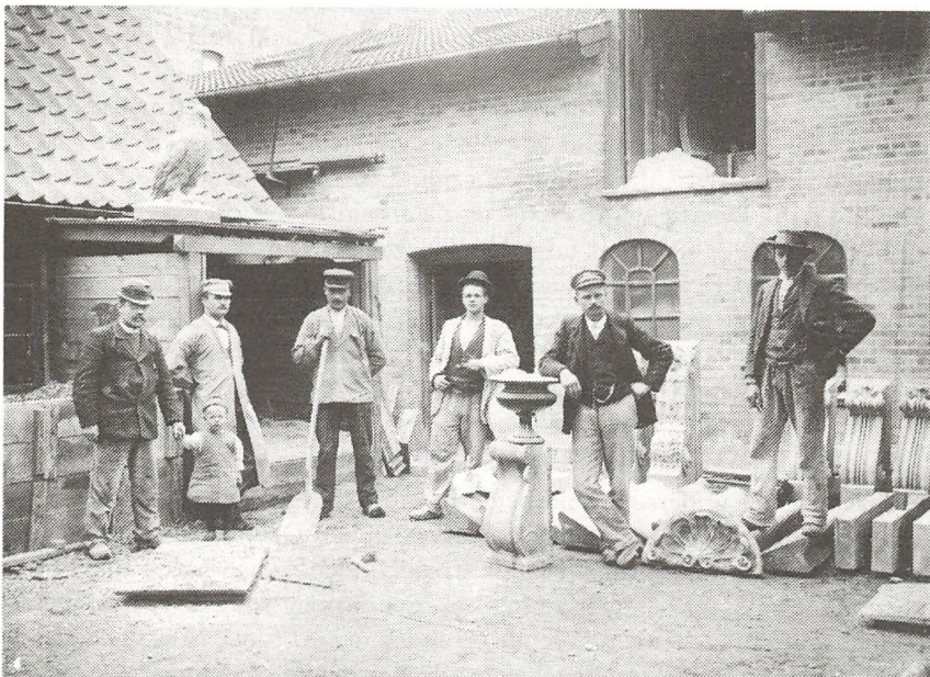
En af de små arbejdspladser i kvarteret. Her Dalhoff Larsens Cementstøberi i Høegh Guldbergs-gade 67, fotograferet omkring 1900. Foto i Lokalthistorisk Samling, Århus.
