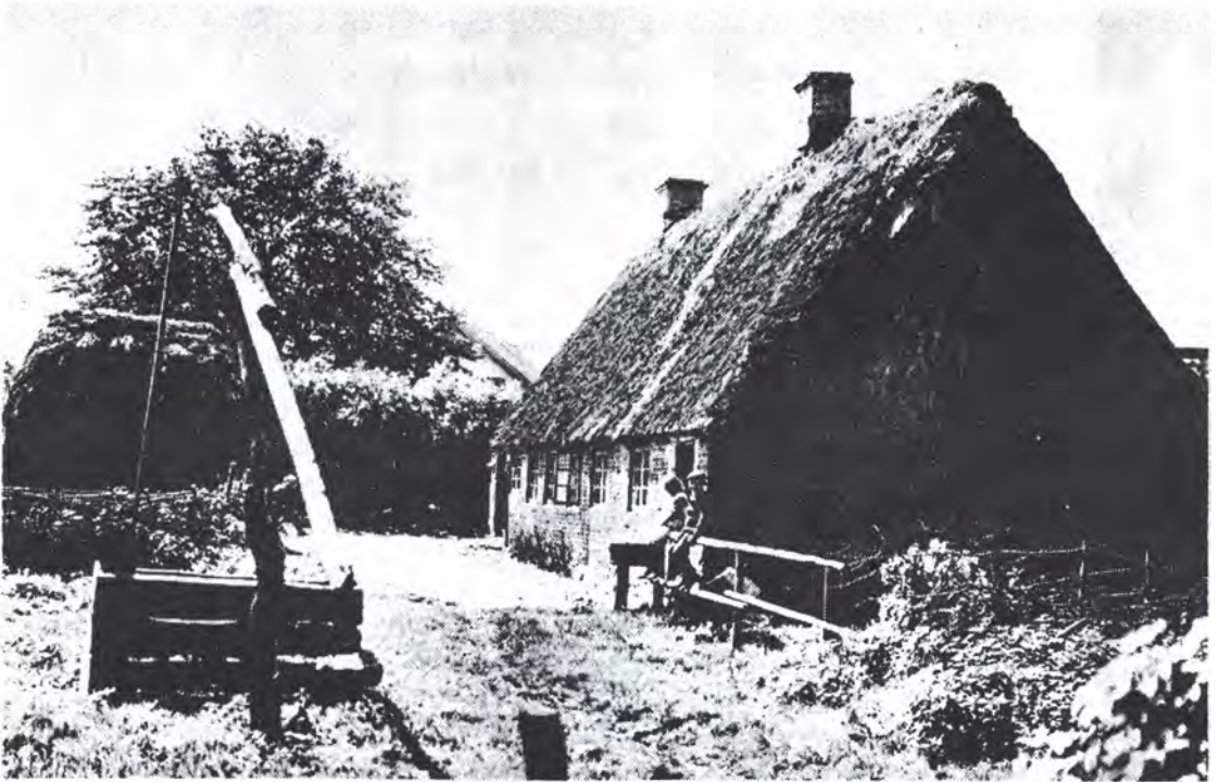
Stuehuset til gård nr. 2a. I baggrunden skimtes gavlen af Uldalls gård. Bemærk den gamle vippebrønd og risgærderne ved huset.
