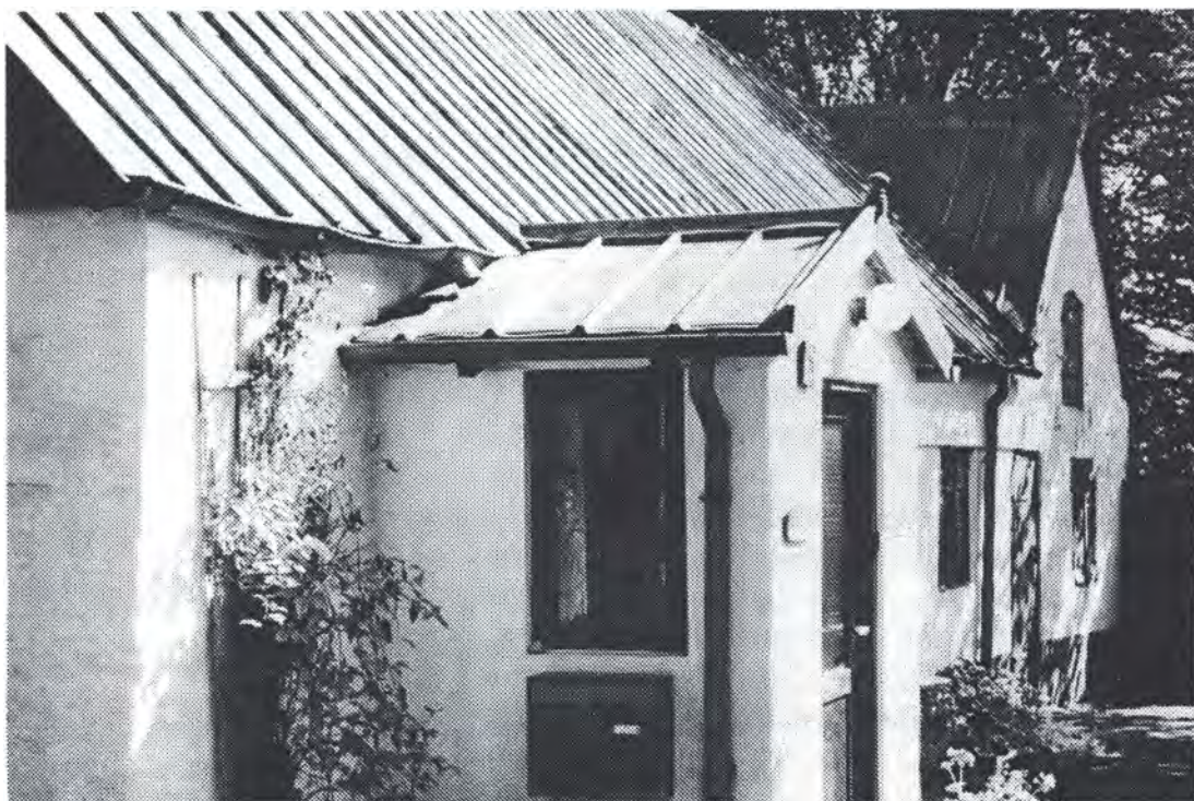
Indgangspartiet til Seemanns hus. Bagest ses gavlen af den lille stald, der hører til huset. Husets bagmur er helt bygget ind i skrænten. (Foto 1994)
