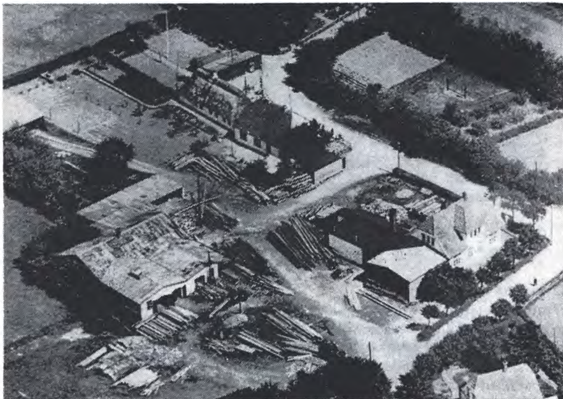
Styding Savværk 1946. Bygningen tv. med skorstenen og gavl mod vest er resterne af den gamle "Hyrups gård". I denne bygning findes stadig gårdens ajlebeholder. (Se gården indtegnet under gård nr. 8).
