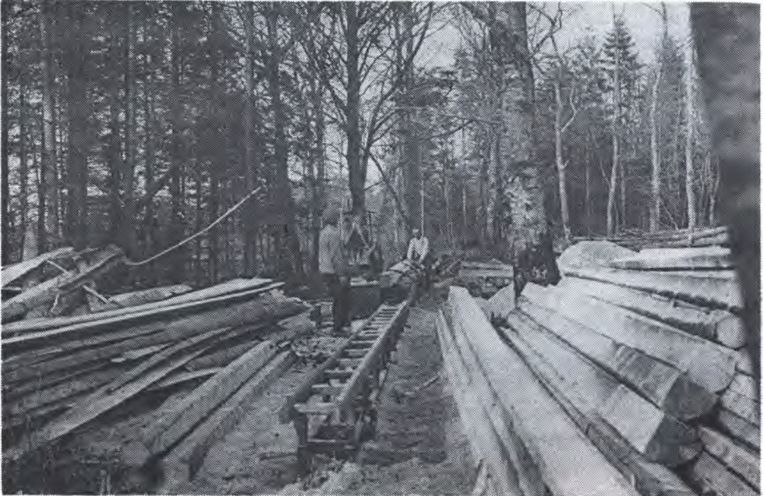
Da Detlef Knudsen ca. 1908 skulle have tømmer savet til sin nye lade, foregik det i skoven på en bloksav trukket af et damplokomobil.
