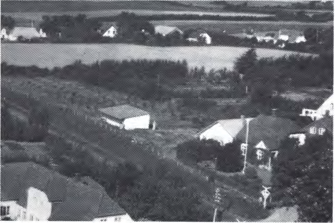
Kresten Sandholdts hus Ringvej 5. Grunden ved laden tv. blev udnyttet til byggeplads.
