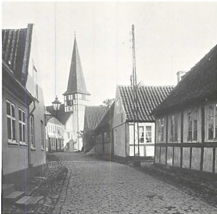
Storegades søndre afsnit ved Lygtestræde. I baggrunden kirken. (Nationalmuseet fot. 1922).
