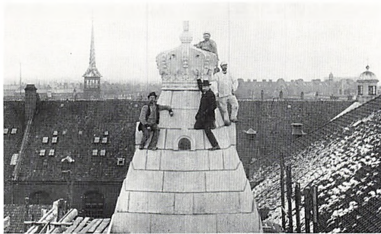
Håndværkere på toppen af det ene spir omkring 1906.
