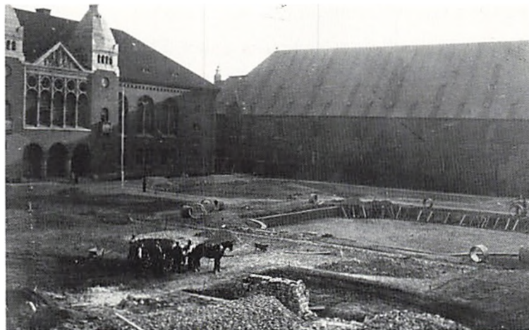
Bassinet midt i haven under udgravning. Ca. 1915.
