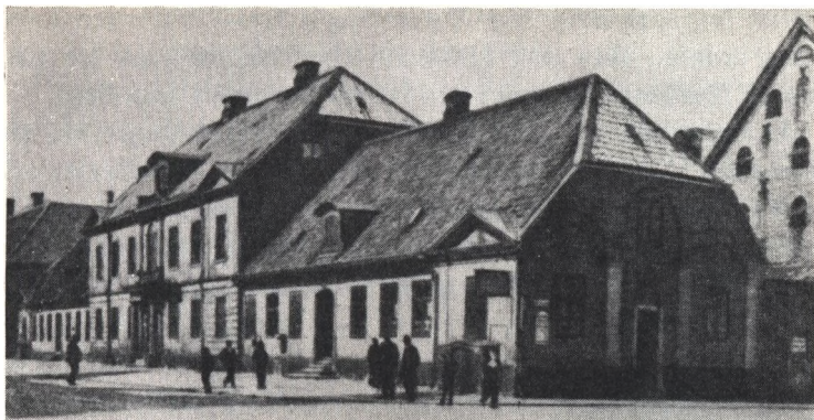
Bagerska fastigheten i kvarteret Lorens Bager vid Östergatan i Malmö. Husen rivna år 1906.
