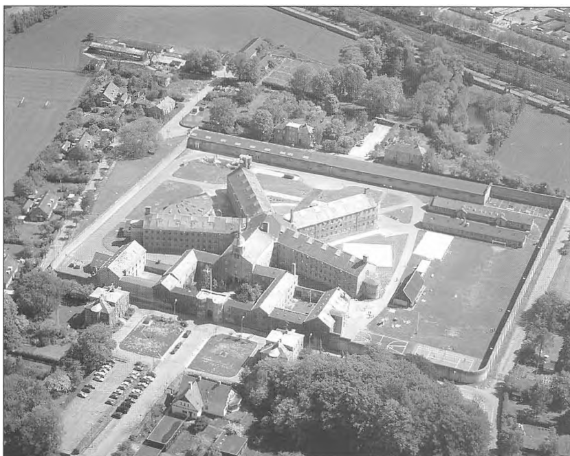
Statsfængslet i Vridsløselille. Bygningskomplekset domineres stadig af de fem fløje med et fælles centrum. Foto: Steen Paulsen (Venligst stillet til rådighed af Statsfængslet i Vridsløselille).
