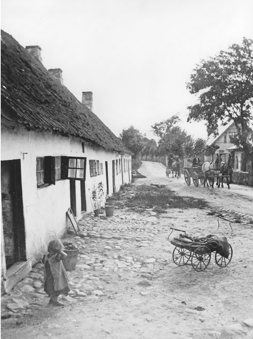
"Lassens Huse" på hjørnet af Helligkorsvej og Børgediget. Typiske fattigrønner med byens nye vandværk overfor (kun bestyrerboligen er synlig). Sådanne rønner anså Fanny Fang ikke for en værdig ramme om et familieliv. Foto ved vennen Kr. Hude kort før nedrivningen 1900. Roskilde lokalhistoriske Arkiv.
