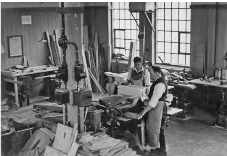
Maskinsnedkeriet på Roskilde Madrasfabrik 1937.
