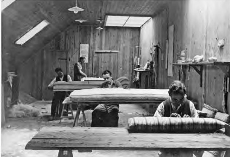
Sadelmagerværkstedet på Roskilde Madrasfabrik 1937.
