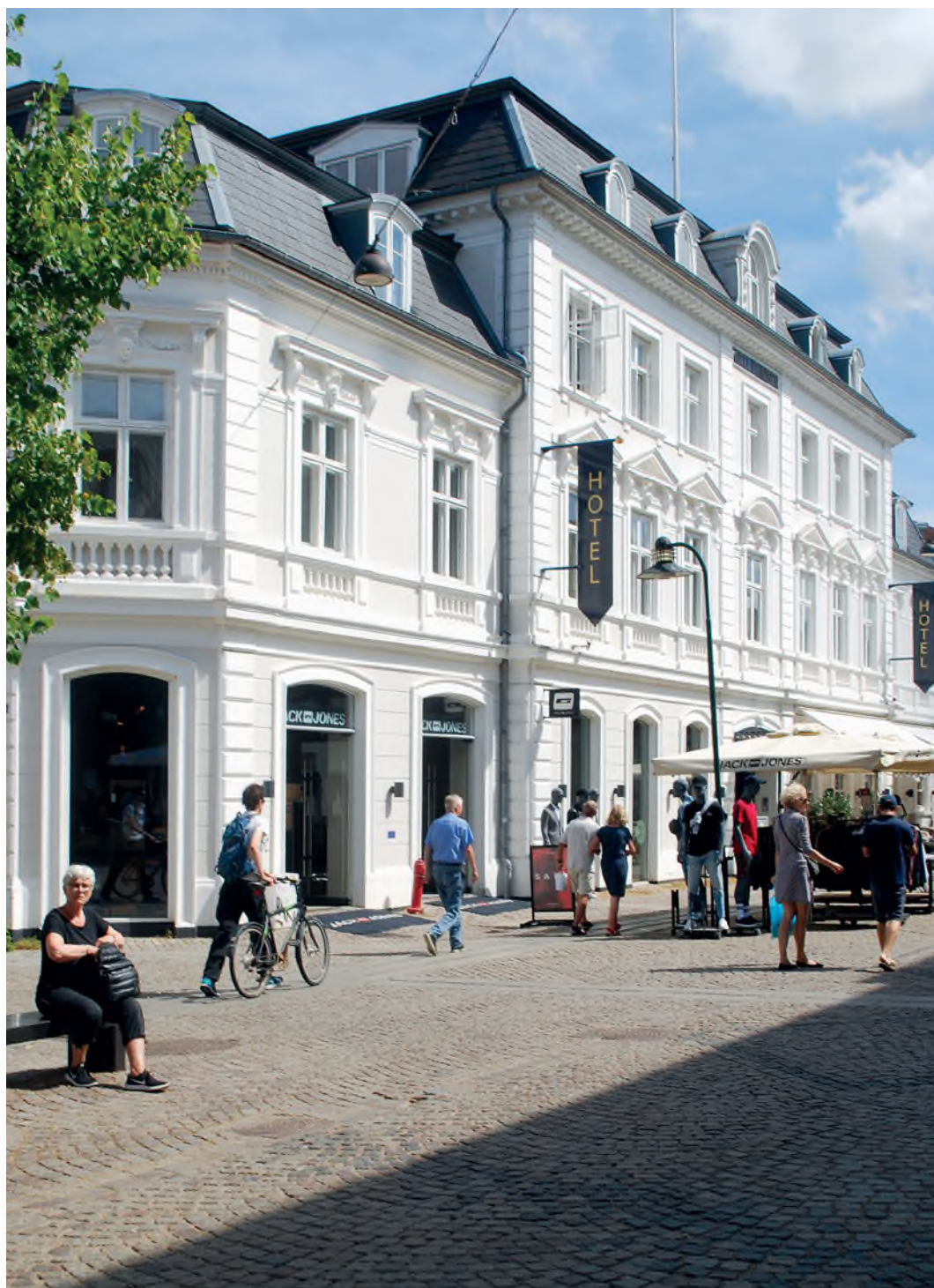
Hotel Prindsen, den statelige bygning opført 1875-76, som vi kender den i dag. Hotellet blev tegnet af en af datidens førende arkitekter, Ove Petersen, der også tegnede Det kongelige Teater og Hotel d'Angleterre. Bygningen er fredet. Foto ved Jeppe Tønsberg 2018.
