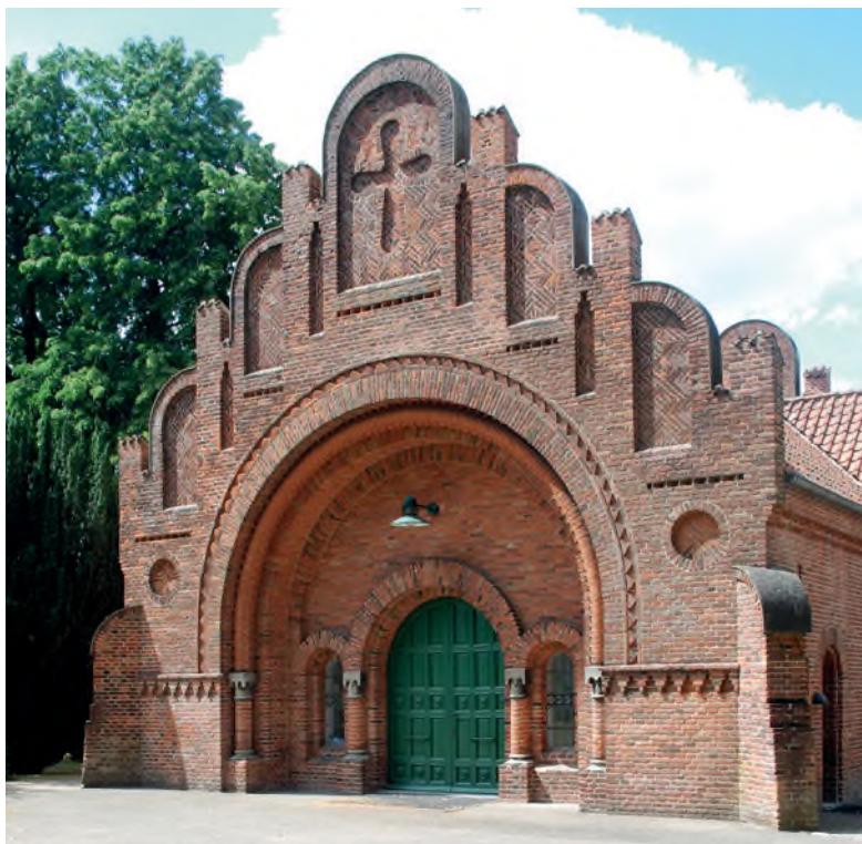
Kapellet på Gråbrødre Kirkegård, som Thorvald selv havde været med til at mure under faderens opsyn, da denne havde byggeopgaven midt i 1850'erne. Siden fik sønnen en vedligeholdelsesopgave på bygningen. Foto: Jeppe Tønsberg 2018.
