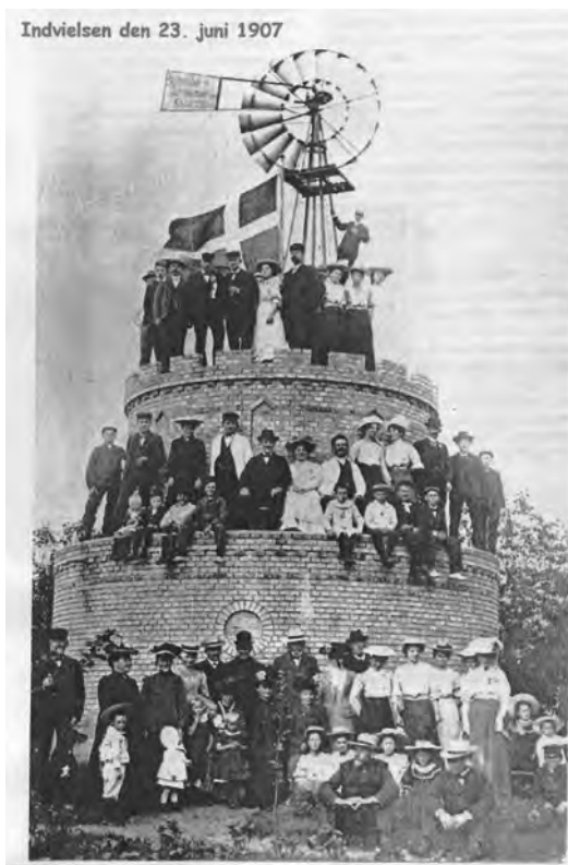
Fig. 8. Osted vandværk blev indviet den 23. juni 1907. Tidligere fik beboerne vand fra de små brønde og kreaturerne fik vand fra gadekæret og andre små søer, de var ofte forurenede. Derfor var det et stort fremskridt for de første 30 forbrugere, da der kom vand i hanerne. I 1961-1965 bygges der et nyt vandværk. Foto fra pjecen.
