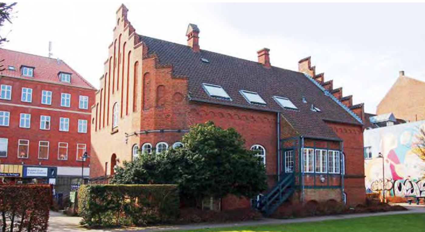
Figur 128. Algade 31 fra havesiden med det runde hjørne og de famøse ovenlysvinduer. Foto: Kurt Buchtrup.
