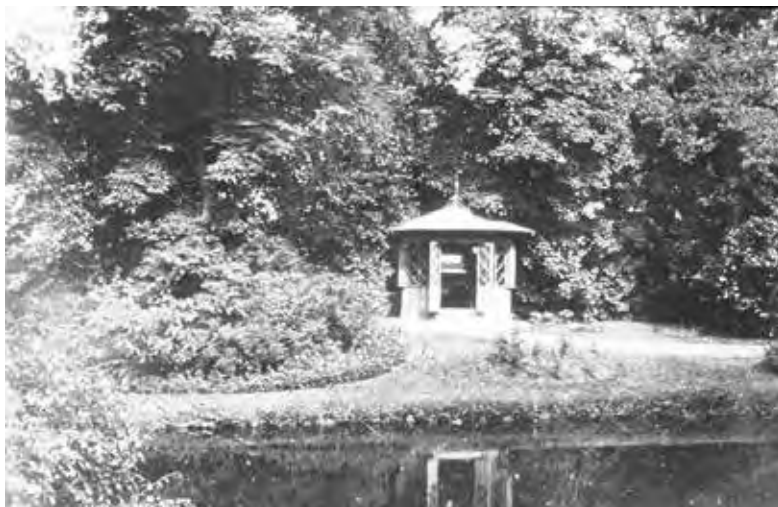
Figur 60. Damernes tepavillon og stien, der førte ud til næsset på Møstingsholm.
