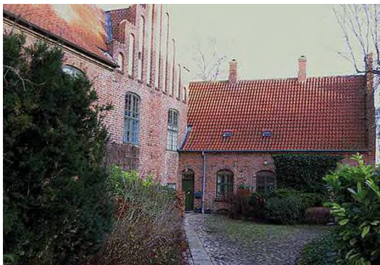
Figur 97. Klosterforvalterboligen. Ved siden af døren anes et vindue i Midterfløjsgavlen, som ikke er angivet på hverken plan- eller facade-tegning. Den kraftige vedbend dækker over endnu en dør, som i dag er blændet på indersiden. Foto: Søren Lyder Jacobsen.
