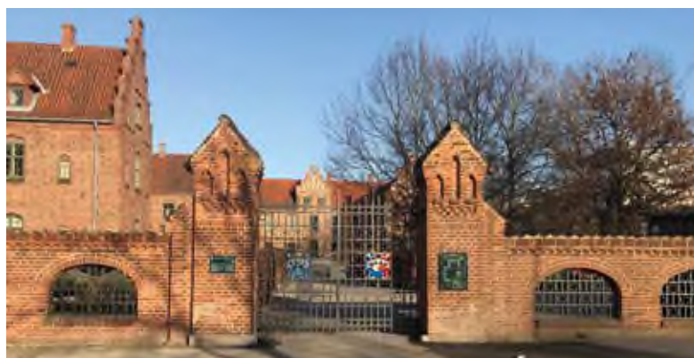
Figur 94. Hovedindgangen, Sankt Peders Stræde 8, som den fremtræder i dag. Porten og de to buesegmenter er fra 1908. På porten ses de renoverede våbenskjold. Foto: Søren Lyder Jacobsen/Roskilde Kloster.
