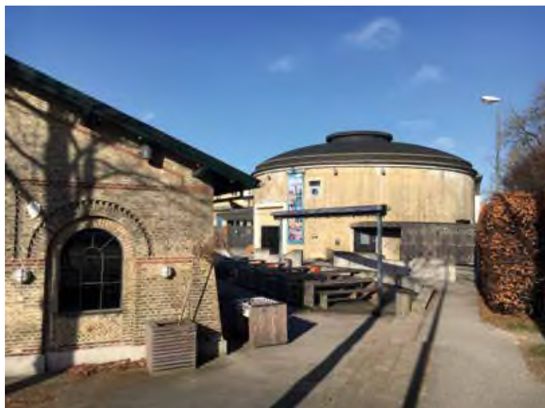
Roskilde Vandværk blev indviet i 1880. Vandværket er i dag lukket, og bygningerne er hjemsted for spillestedet Gimle. Foto Henrik Denman 2023.
