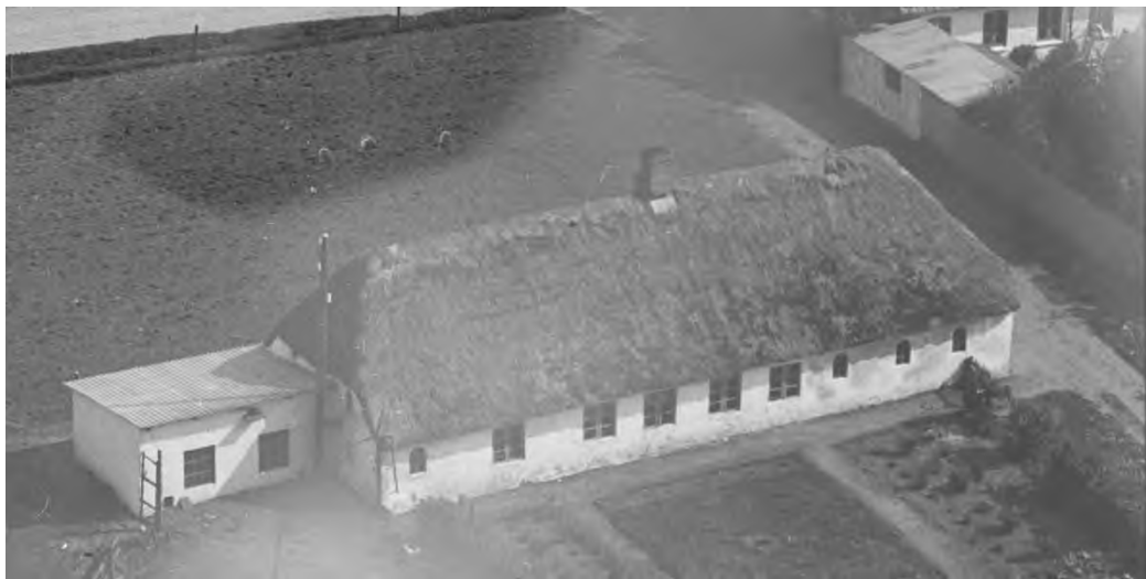
Det gamle skolehus i Øster Åbølling? Nedrevet ejendom, erstattet af et enfamiliehus i 1961, Øster Åbølling Vej 34, 1948-52 (Aalborg Luftfoto, Det Kgl. Bibliotek).
