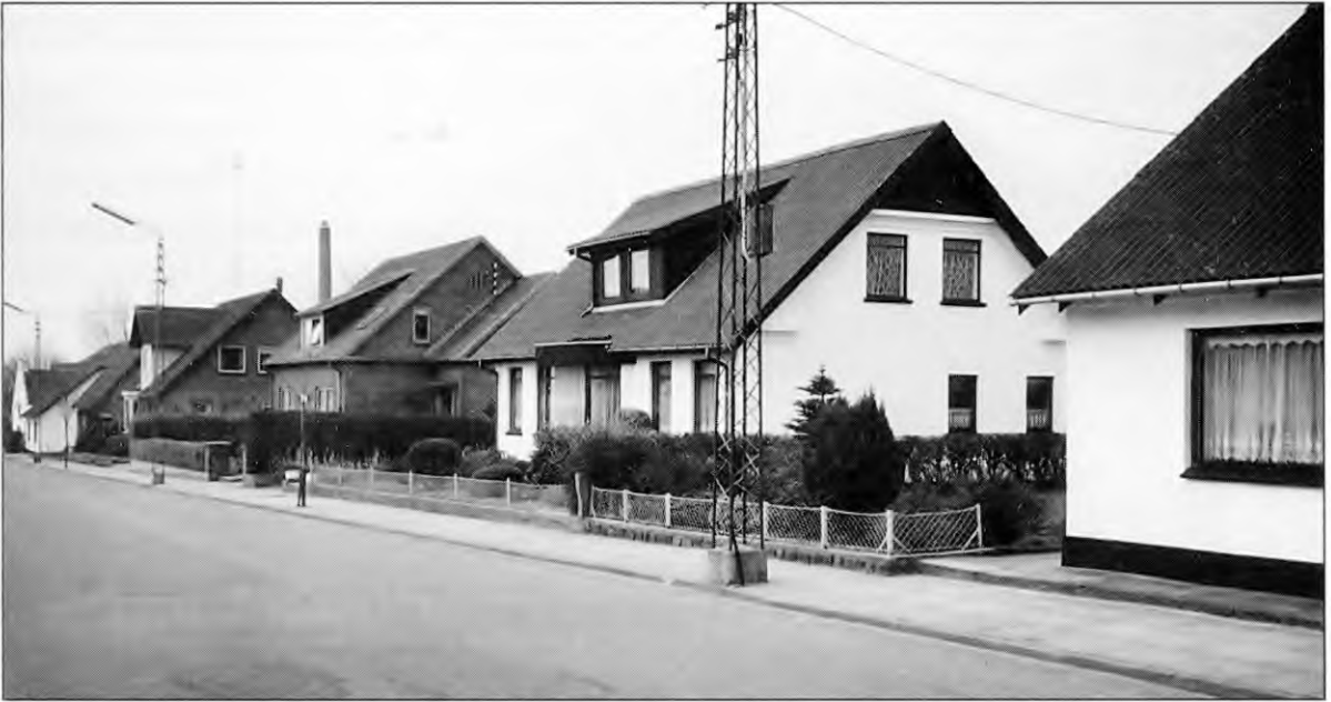
Borgergade 20, 22, 24 og 26 - der alle med undtagelse af nr. 24 - oprindeligt var opført med teglstenstage.
