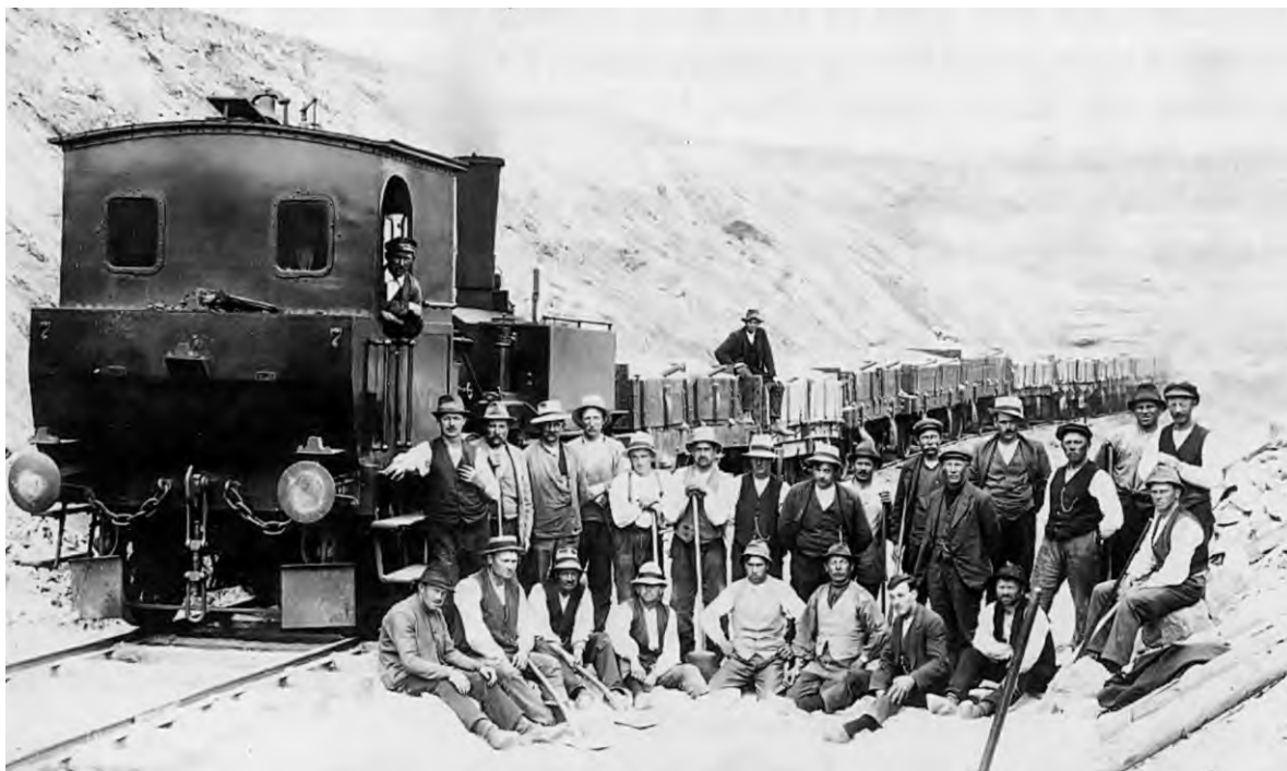
Lokomotiv med tipvogn i sandgraven ved Hellum, hvorfra materiale hentes til jernbanevolden nord for Klokkeholm.
