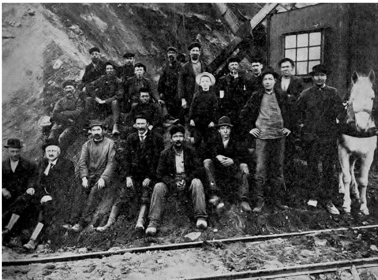
Børstesjak med gravemaskine og tipvognshest på dæmningen mellem Gjøl og Øland. Nederst til venstre formanden og entreprenøren. "Flyver-Olsson" foto 1913.
