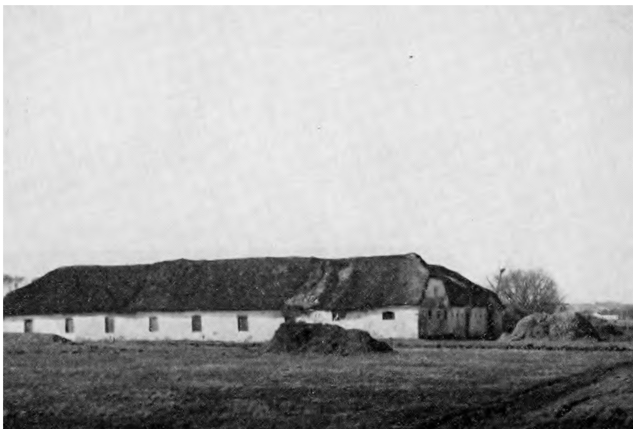
Udflyttergård på Sønderholm mark, opført omkring 1830, med forkelemme i laden i stedet for kørelo, Jeppe Aakjærs digt "Rugen køres ind" har udødeliggjort denne besværlige form.
