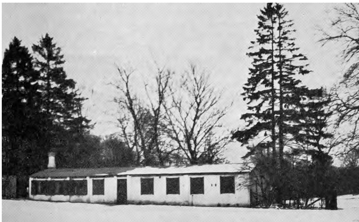
"Dramhuset" på markedspladsen i Skørping stationsby, opført som anneks til kroen i 1913, da markederne - og stationsbyerne i det hele taget - havde deres største tid. Huset bar sit kælenavn med fuld ret.
