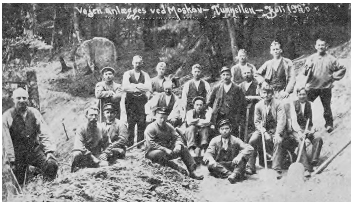
Pause under arbejdet med at bygge underføring ved Moskov holdeplads i Skørping sogn. Overgaard foto. 1920
