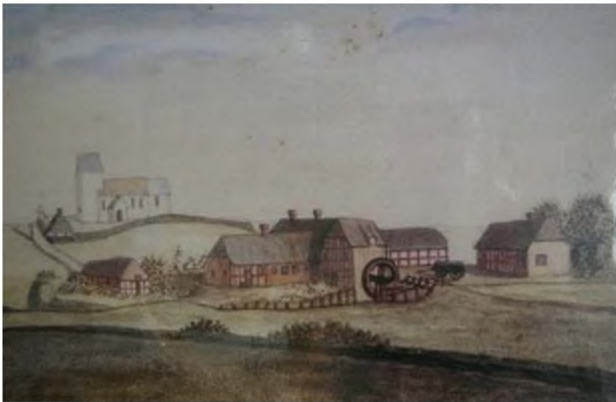
Lydum Vandmølle formentlig i slutningen af 1700 tallet. Møllen drives tilsyneladende af et stort underfaldshjul og facaderne består primært af bindingsværk og stråtag. Det er ikke usandsynligt, at den nuværende mølle er bygget oven på fundamentene på den gamle mølle, der ses på tegningen.
