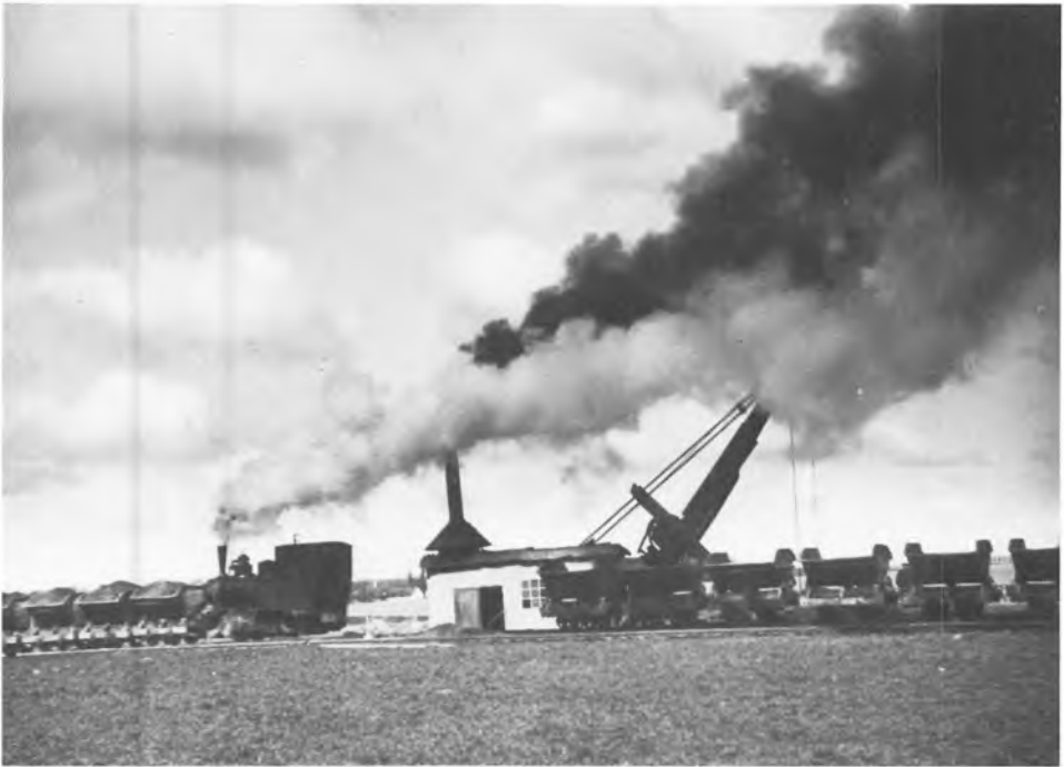
Gravemaskinerne, der arbejdede på land, fyldte de opgravede jordmasser på lange tipvognstog, som kørte dem bort
