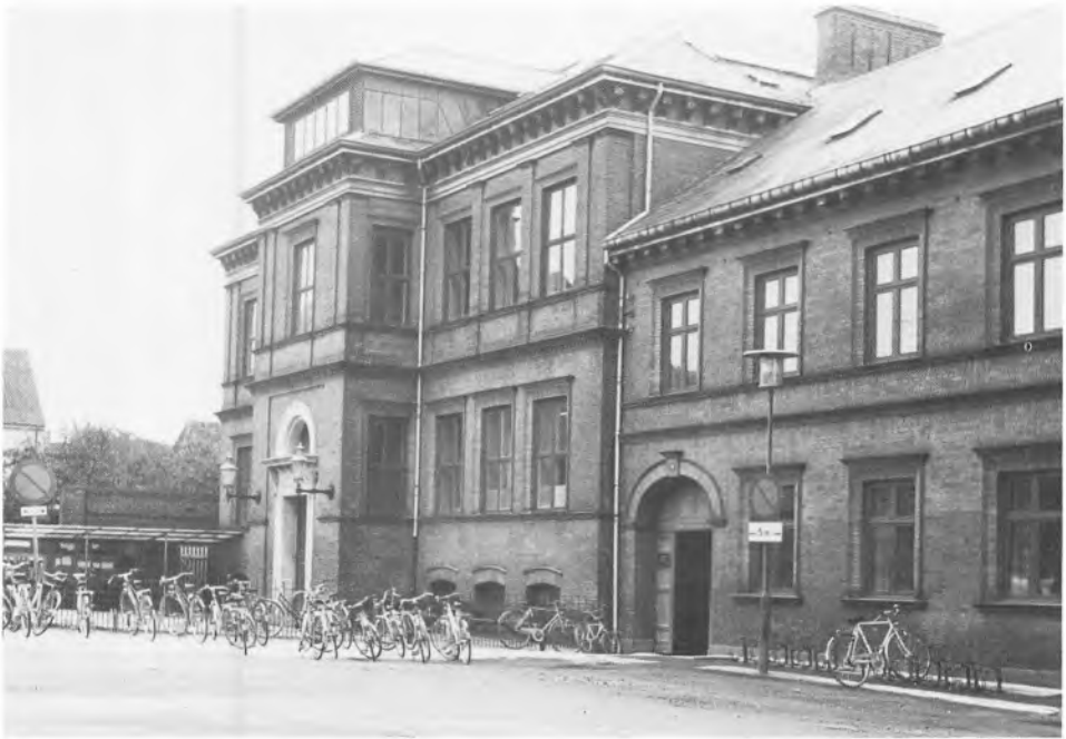
Skolen på Sct. Peders Kirkeplads, der er dømt til nedlæggelse i 1988
