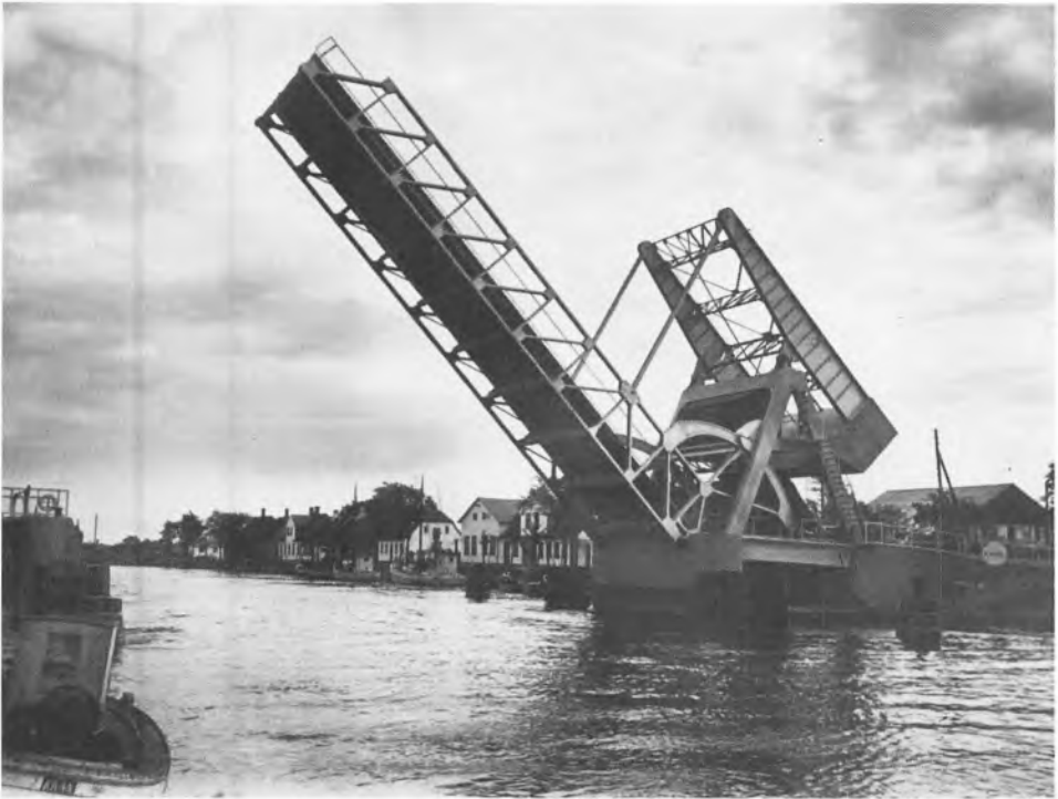
I Karrebæksminde blev den gamle, maleriske træbro erstattet af en ny og moderne med beton-kontravægt
