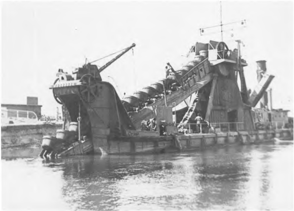
En af de hollandske gravemaskiner, »Gymp«, som deltog i arbejdet med udgravning af kanalen gennem marker og enge
