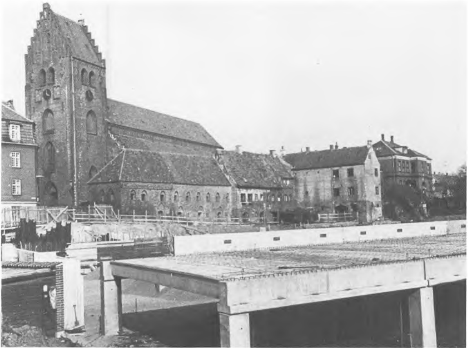
Bredstræde-parkeringen i to etager med plads til 450 biler under opførelse.
