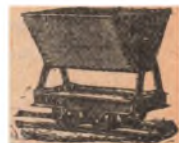
Wagon, Type 25 c, med gradvis virkende Tippe- Indretning til Jordtransp.
