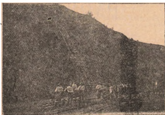
Fotografi af det hydrauliske Skraaplan (Decauvilles System), der er blevet antaget af Hyen Gents Bestyrelse for at løfte fra Rhone- Floden paa en Skraaning af 50 pct. 32,000 Kubikmeter Grus til den nye Kirkegaard St. Georges.
