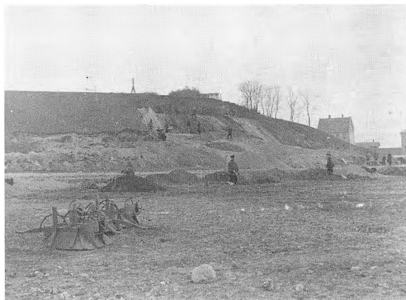
I forbindelse med anlæggelsen af Østboulevarden fra midt i 1870'erne til 1892 hortgravede man en del af Knudrisbakken. Det egentlige anlæg på bakken blev inddraget til kirkegård i 1912. (Foto i Begravelsesvæsenets arkiv).
