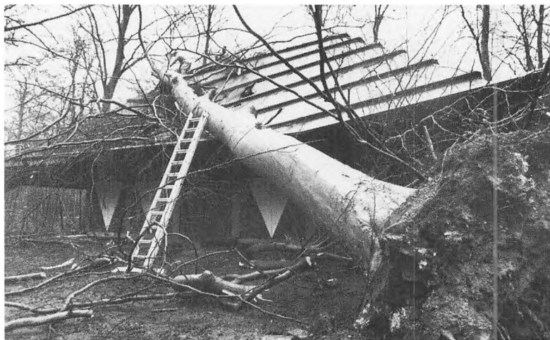
En orkanagtig storm fredag 26. januar vælter et 15 meter højt bøgetræ ned over Aarhus Pigegardes hus ved Tivoli-Friheden.
