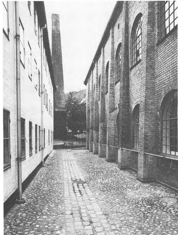
Smøgen mellem gårdanlægget Studsgade 33 og den gamle industribygning, der oprindeligt var dampværk.
