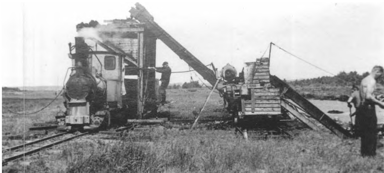
Fig. 6. Pladderet køres frem til læggepladsen fra ælteværk 28 på Bodal. Foto Gudrun Pedersen.
