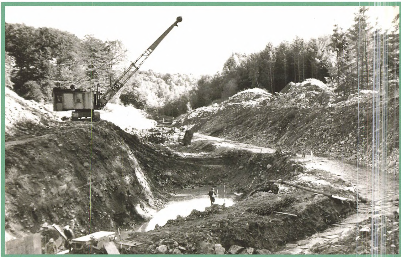
Åregulering og tunnelbyggeri ved Bromølle. I slutningen af 1950'erne omdannede vandstandssænkning og åregulering tørveområderne til landbrugsjord. Ved Bromølle blev det nødvendigt at grave åen langt ned i terræn og rørlægge den i en 900 m lang cementtunnel. Lokalhistoriske Arkiv Høng.
