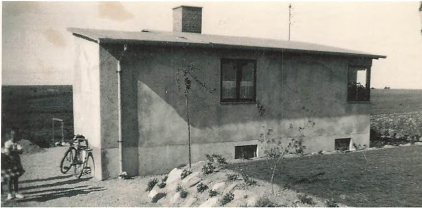
Fig. 18. Huset i Svogerslev. Huset havde stået i mosen og været formandens hus. Willy gravede ud og støbte kælder. Herefter blev skelettet af huset opført. I alle årene har Agnes og Willy passet huset, bygget om og til. Det åbne land, der anes rundt om huset, er nu vokset til, og Fru Koch bor stadig (2008) i huset fra mosen. Privatfoto.
