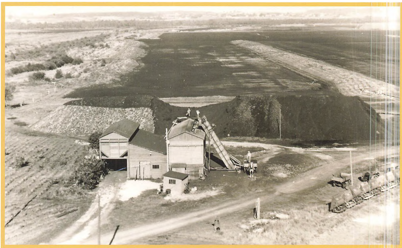
Muldbjergs briketfabrik. Store områder i Store Åmose var lagt ud til harvning af tørvesmuld. Denne blev presset til brikker, der hobede sig op i kæmpebunker nær produktionsanlæggene. Selv om metervis af tørv på den måde blev gravet af Åmoserne, forekommer der stadig tørv med kulturarv bevaret mange steder i bassinerne. Stenlille lokalhistoriske Arkiv.
