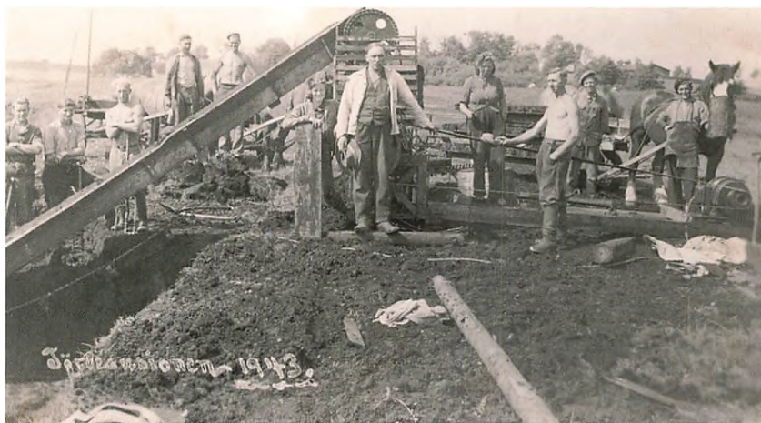
Fig. 2. Tørvesjak ved dyndelevator og tørvepresse. Willy står som nummer tre, i venstre side af fotografiet. Det var typisk med disse opstillede fotos af tørvesjak, hvor gruppen af arbejdere blev foreviget. Fotograf ukendt. Privatfoto.
