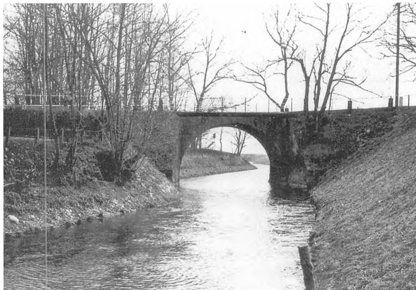
Fig. 3. Bromølle Bro fotograferet i 1937. Broen blev opført i 1870'erne og kom forholdsvis uberørt gennem reguleringen i 1930'erne. Man kan se de høje brinker, som voldte Store Åmoses lodsejere så mange problemer. Så sent som i 1938 og 1946 var der store jordskred i brinkerne, som blokerede Åmose Å. Broen på billedet blev revet ned og erstattet af den nuværende Bromølle Bro i forbindelse med reguleringen 1957-64. Foto fra Svinninge lokalhistoriske Arkivs samlinger.
