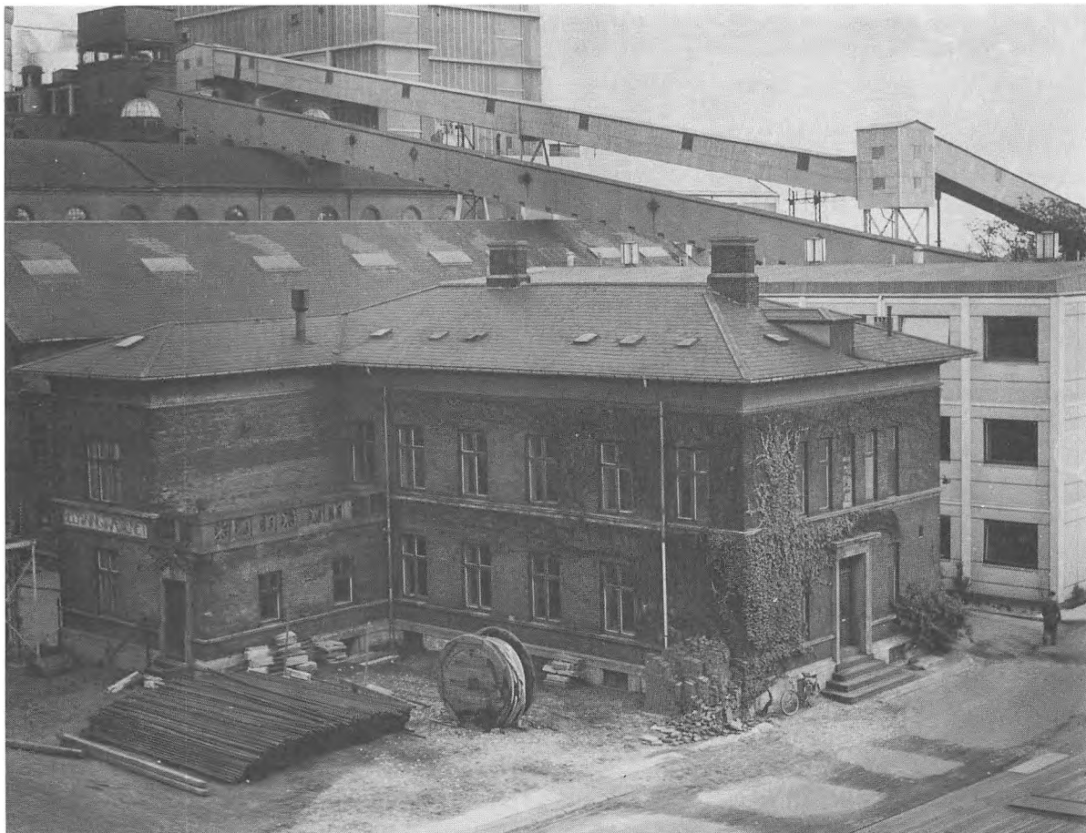
I 1955 var der ikke længere plads til Belysningsvæsenets gamle administrationsbygning. Den blev nedrevet for at give plads for en større udvidelse af de kommunale produktionsanlæg. Værkerne var nu også blevet leverandør af varme. (Lokalhistorisk Samling).
