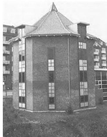
Mandag den 18. marts indvier Boligforeningen Fagbo nye lokaler i DSB's tidligere vandtårn ved Ringgadebroen efter en ombygning for 10 mio. kr. (Foto: Dan Jakobsen).
