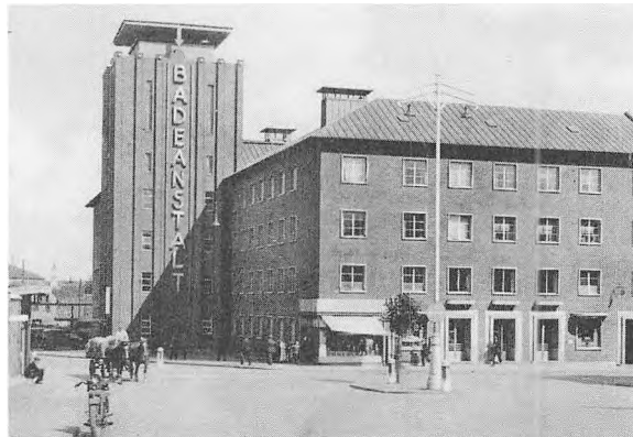
Århus kommunale Badeanstalt var institutionens officielle navn, men i daglig tale hed den Svømmehallen. Her er den fotograferet fra vest i 1934. Hovedindgangen er de tre døre i midten, som fører ind til en vestibule, som er for lille. I hvert fald er der dårligt plads til en skoleklasse, og forfatteren af disse linjer har af samme grund i sin mellemskoletid tilbragt en hel del tid med at vente udenfor, uanset vejret. (Foto i Lokalthistorisk Samling)
