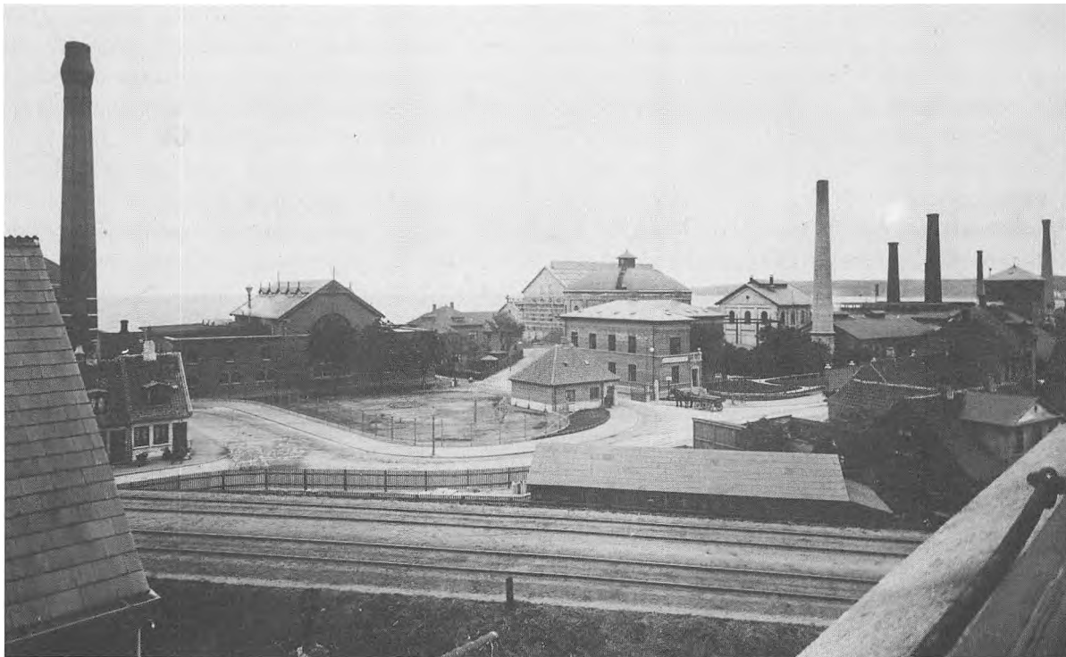
12. februar 1901 blev Århus Elektricitetsværk officielt åbnet. Det blev efter megen diskussion placeret ved siden af det kommunale gasværk. Det var en ideel beliggenhed tæt på havnen og alligevel centralt for forsyning af byen med gas og el. Elværket var indrettet i rødstensbygningen med den markante tagrejsning. Til højre i billedet blev der indrettet administration. Bag administrationsbygningen ses den store gasbeholder. Billedet giver et godt indtryk af området med dets mange skorstene, jernbanespor samt rester af den gamle bebyggelse med de typiske småhuse, der siden blev ryddet for at skabe mere plads til det hurtigt voksende elværk. (Lokalhistorisk Samling).
