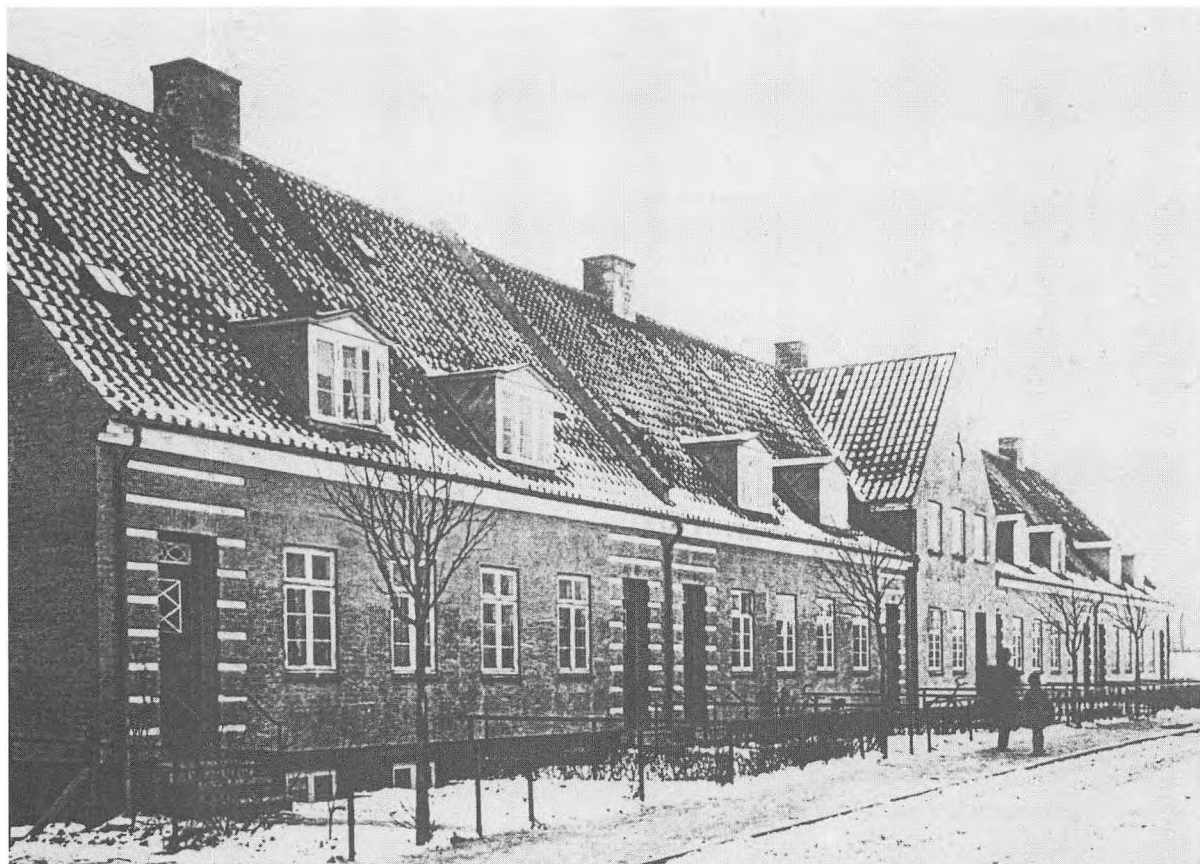
Nogle af rækkehusene på Poul Martin Møllers vej en vinterdag i begyndelsen af 30'erne. Husrækken består af fire dobbelthuse og et midterhus. Dobelthusene er af hensyn til brandfaren adskilt af en mur i tagetagen, som er ført op gennem taget. (Foto I Lokalhistorisk Samling)
